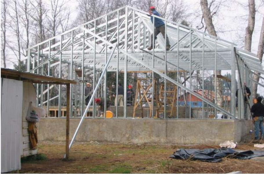
*Figura 3.9. Muros perimetrales de una vivienda de acero galvanizado.*
