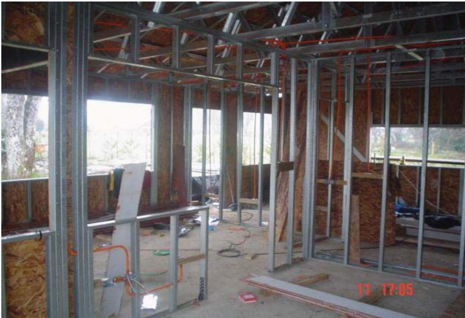
*Figura 4.0. Muros interiores de una vivienda de acero galvanizado.*
