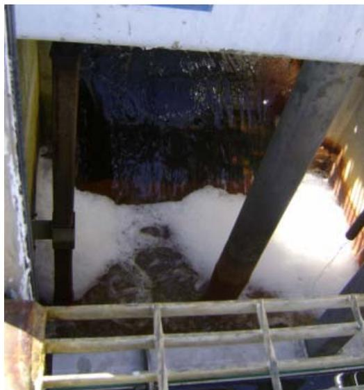
Figura N°16, Cámara de floculación 1
