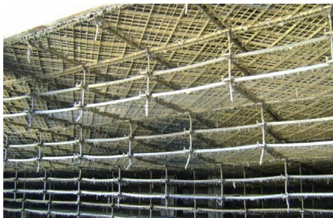
Figura N°13, Bandejas receptoras
