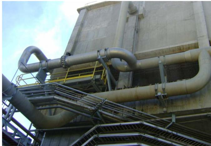
Figura N°11, Ducto de entrada del efluente a las torres de enfriamiento
