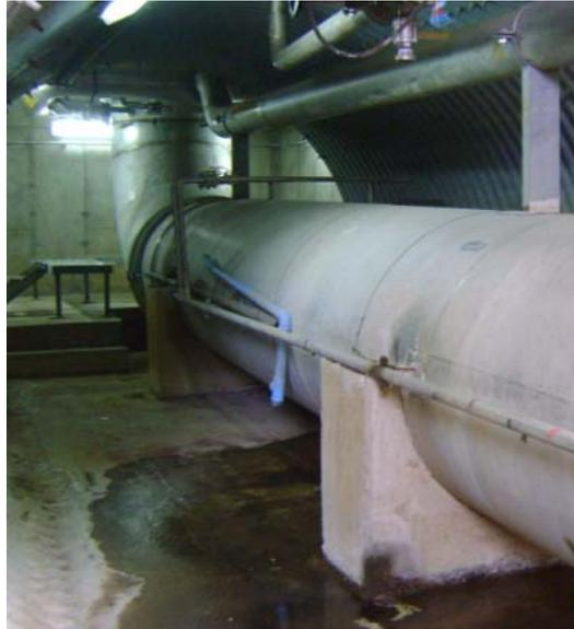
Figura N°17, Ducto de entrada del efluente al clarificador de flotación 1
