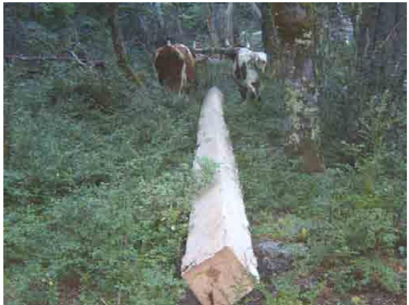
Foto 2: movimiento de una pieza de coigüe de 18 por 22 pulgadas de escuadría con un largo de 4,00m
