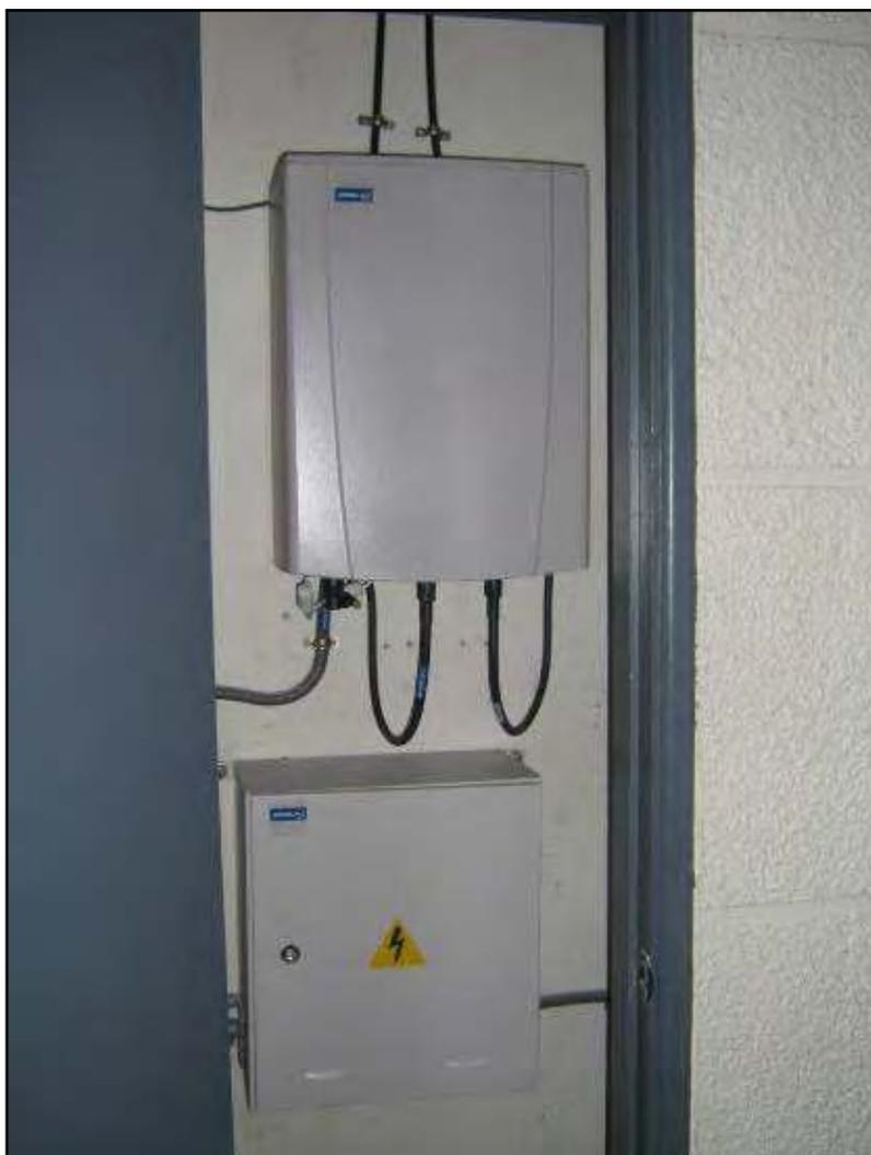
*Figura 100. Micro BTS 2308 Ericsson y rectificador de energía.*
