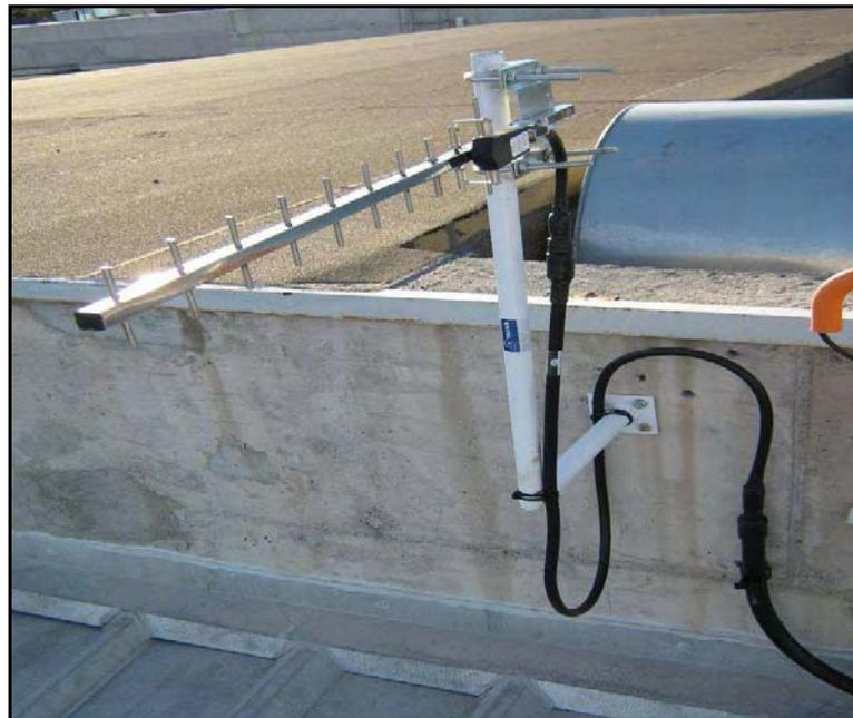
*Figura 34 Antena Yagi para 1900 (MHz)*
