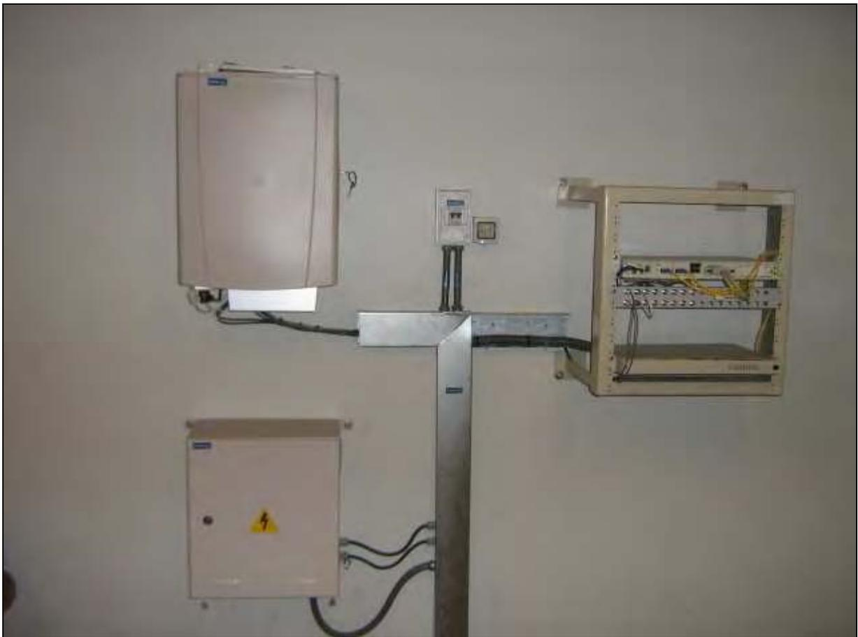
*Figura 19. Micro BTS Ericsson con Rectificador de energía y Trama con fibra óptica.*
