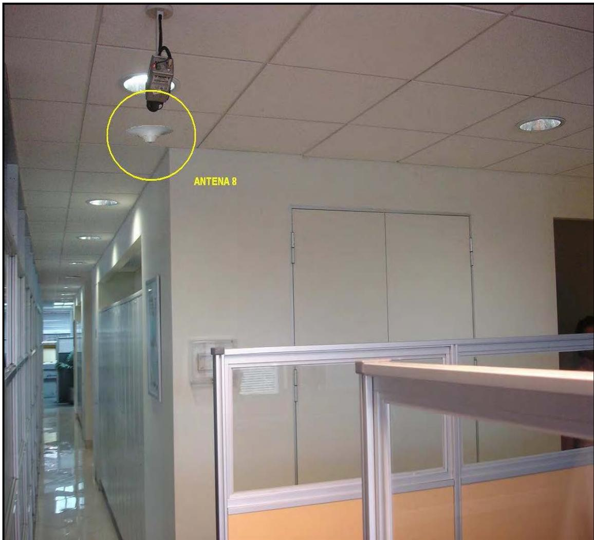
*Figura 48. Fotomontaje Antena 8 – Piso 4.*
