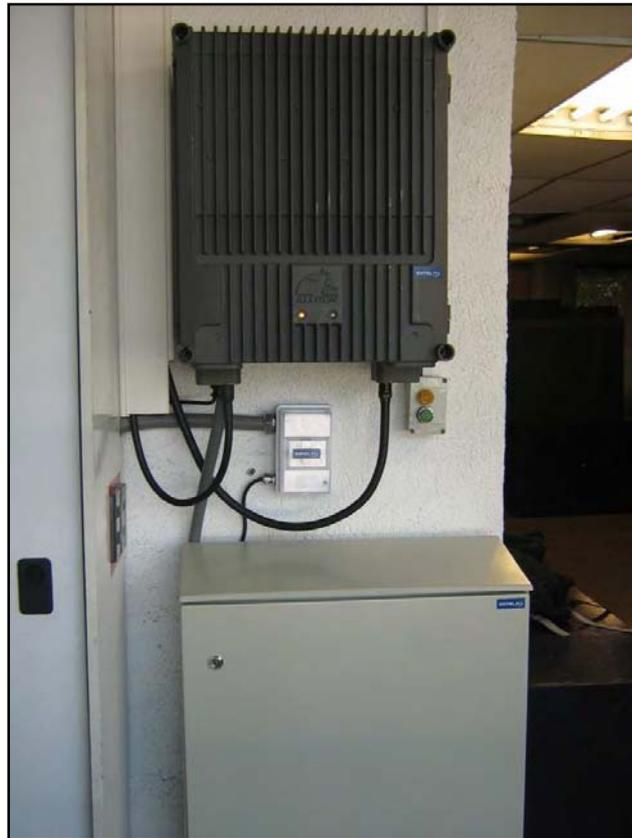
*Figura 25. Repetidor Allgon de canal selectivo.*
