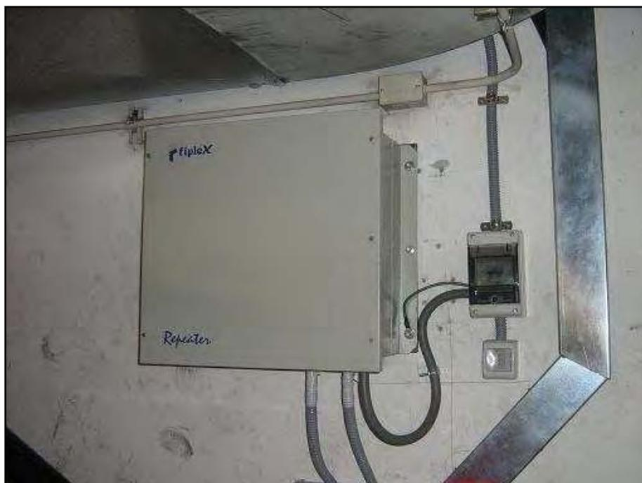
*Figura 24. Repetidor Fiplex de Banda Selectiva.*
