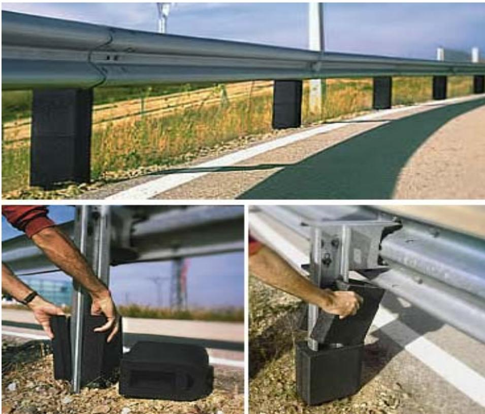
*Fotos N° 44,45 y 46: Instalación de protectores de caucho reciclado en barreras de contención.*
