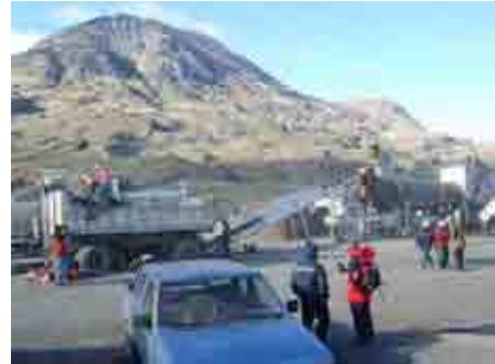
El proceso de colocación se realizó con una finisher del año 2003, la cual entregó niveles de compactación del orden del 85% respecto de la densidad de diseño. En terreno se observó que la mezcla fabricada con ligante asfalto – caucho tenía poco desplazamiento en comparación con la multigrado, debido fundamentalmente a la viscosidad de la mezcla en el momento de su colocación.
