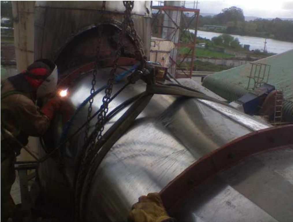
Fig. 25 Colocación flange en un ducto
