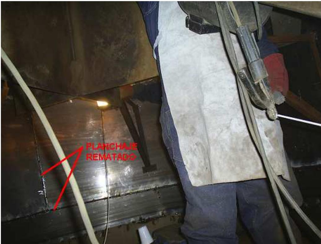
Fig. 34 Muestra planchaje rematado dentro del ciclón
