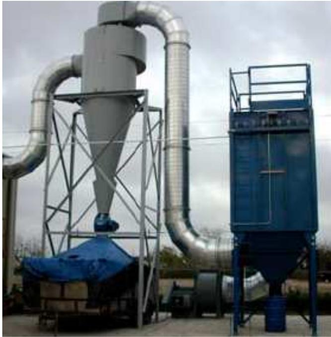
Fig. 41 Muestra un ciclón trabajando en conjunto con un filtro de manga
