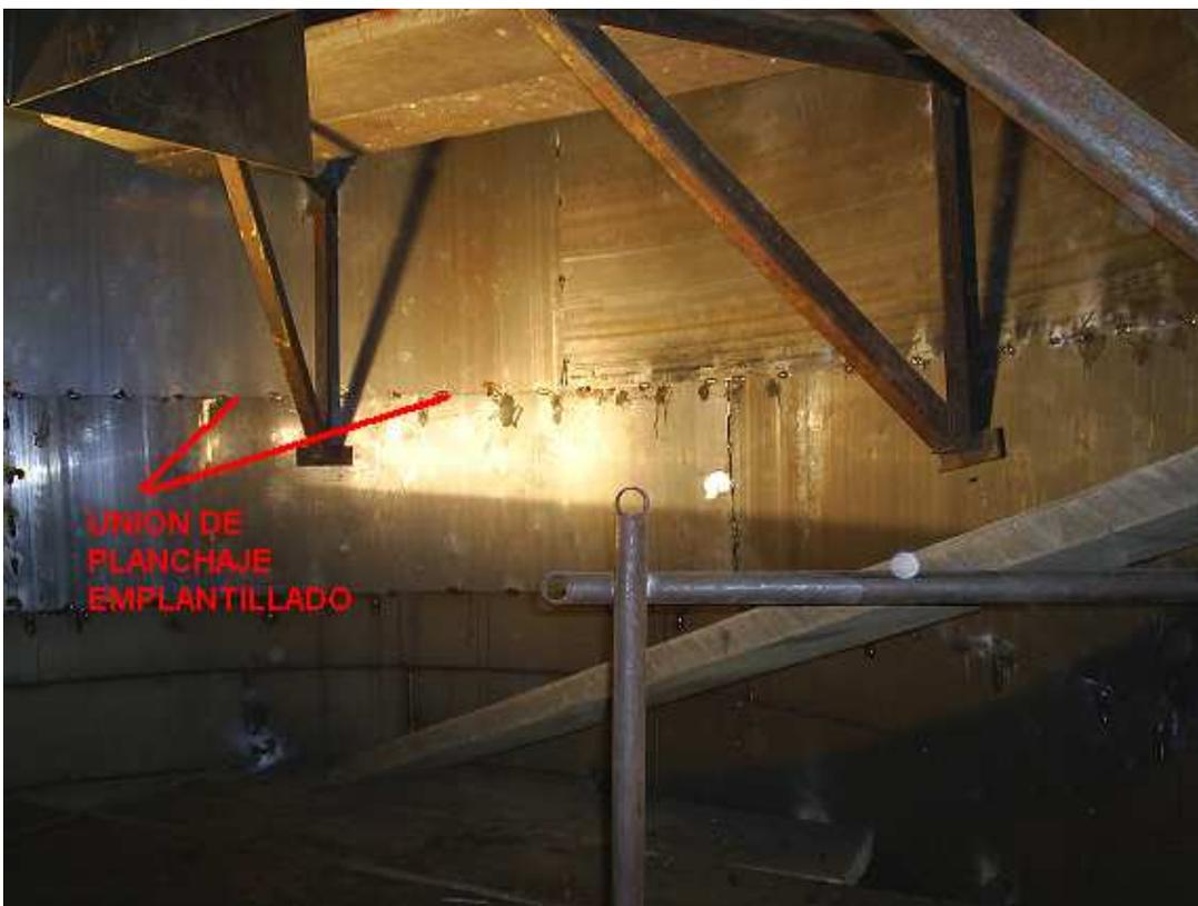
Fig. 33 Muestra planchaje emplantillado dentro de un ciclón
