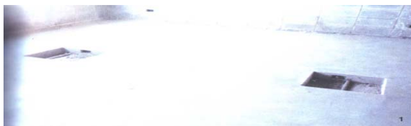
(Foto 1) Espacio dejado en contrapiso para colocar altoparlantes que permitan hacer vibrar el suelo de madera.
