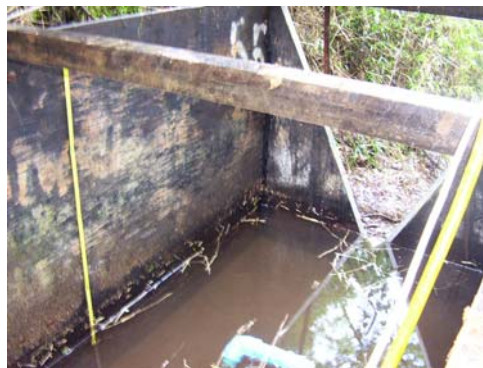
Figura 6. Regla graduada en vertedero
