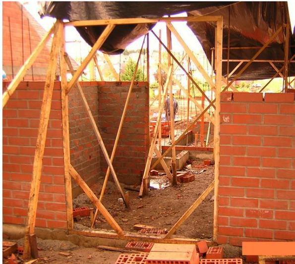
Figura 8: Premarco para identificar vanos en muros.
