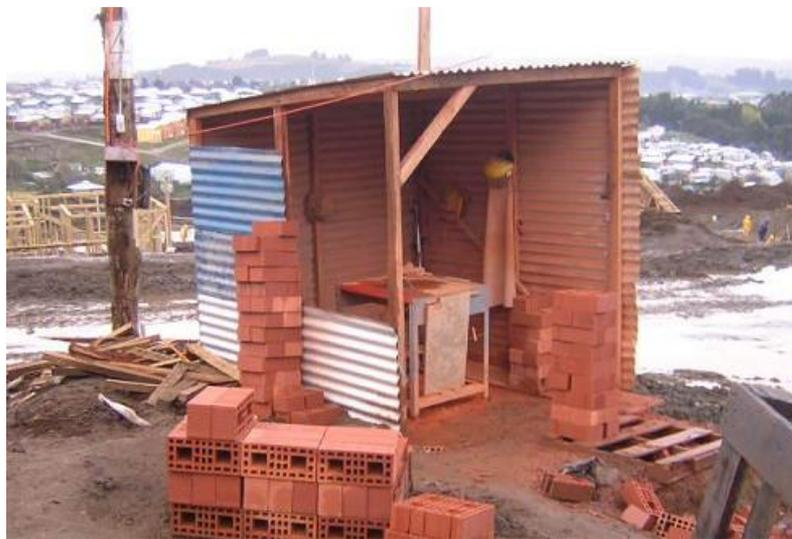
Figura 6: Banco de corte de ladrillos.
