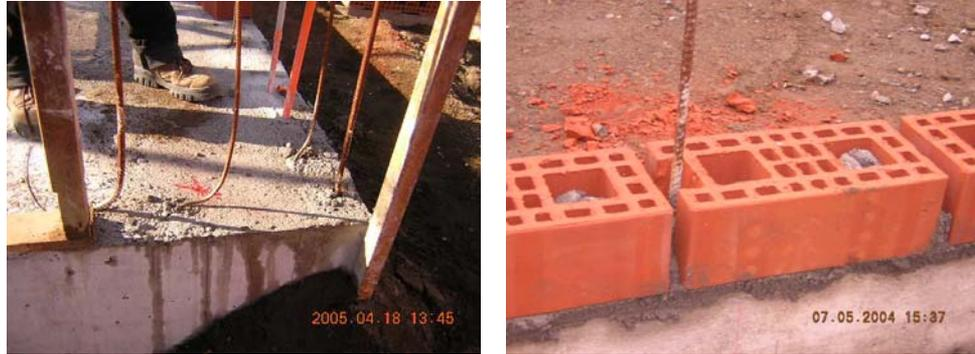
Figura 13: No Conformidades por desplazamiento de los tensores o barras.
