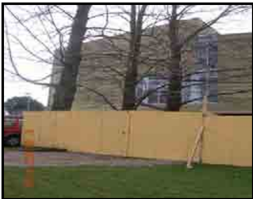
Cierro perimetral de la obra.
