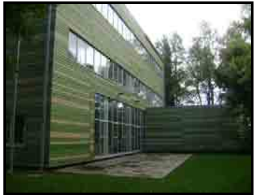
Terraza, antes de ampliación.
