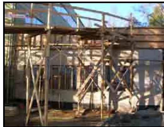
Ampliación del edificio.
