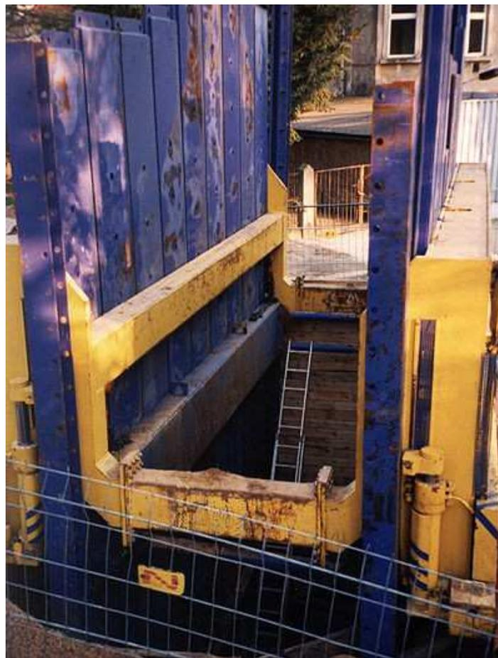
*Fig. 7.02 Sistema de entibaciones hidráulicas PRESSBOX..*
