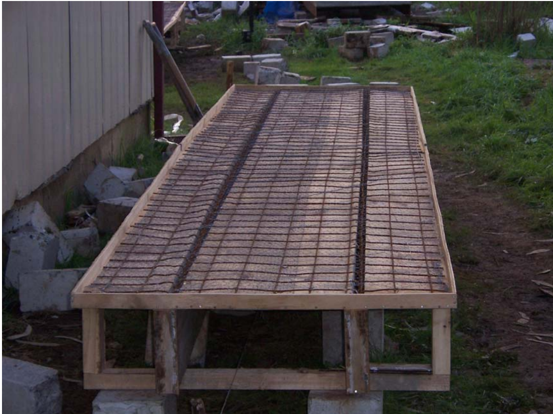
Fotografía 4.2 La enfierradura dentro del moldaje.
