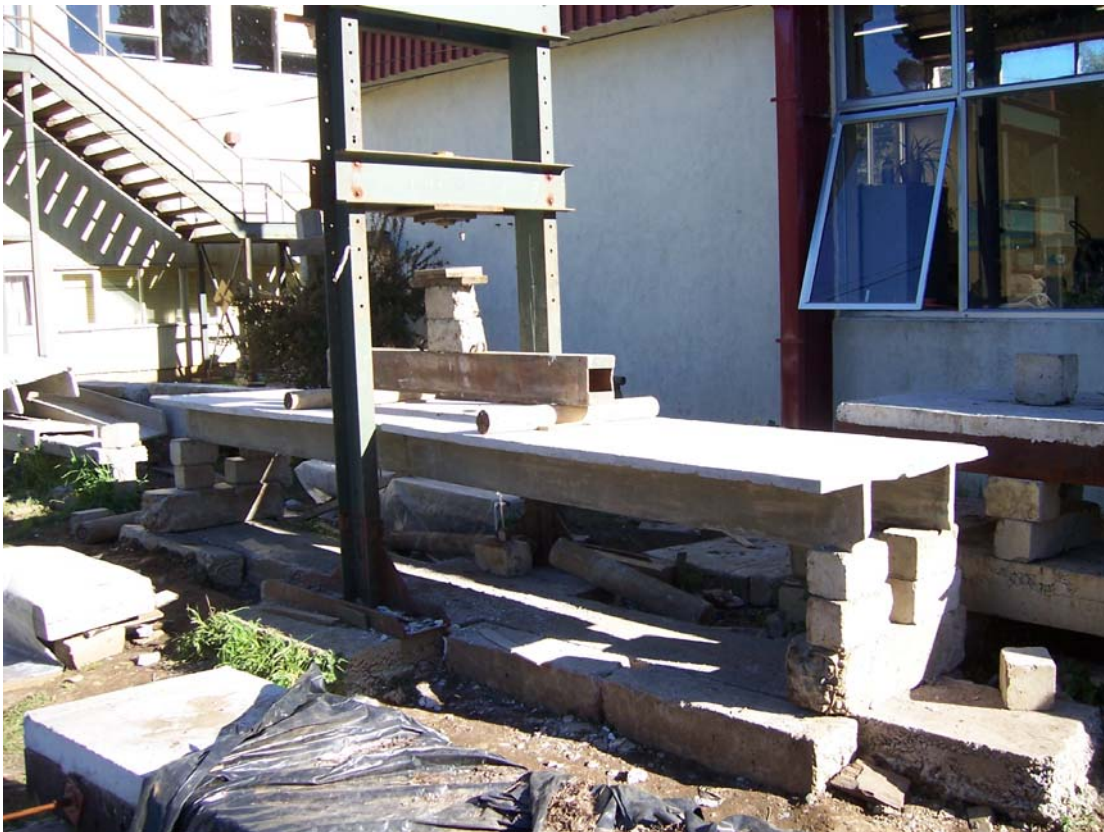
Fotografía 4.5 Losa de ferrocemento.
