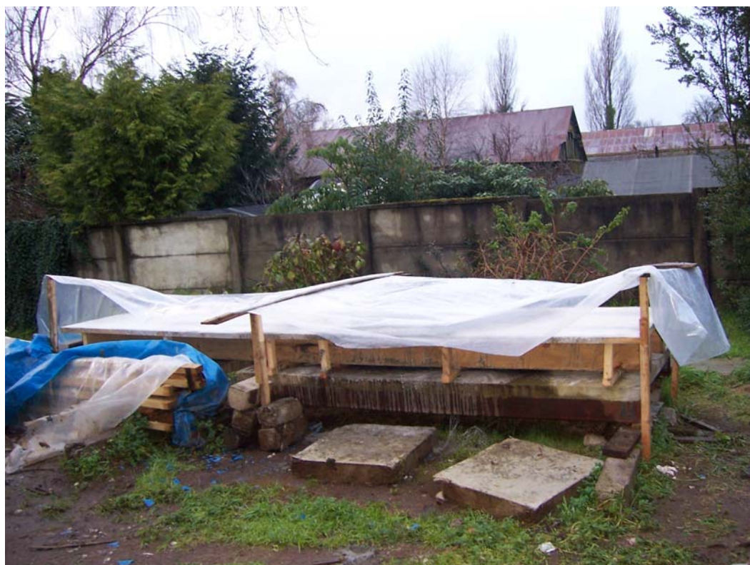
Fotografía 4.3 Curado de la losa.
