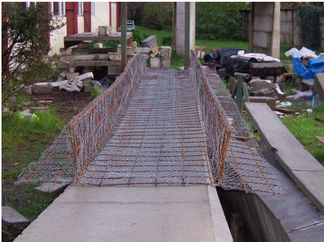
Fotografía 4.1 Plano general de la armadura.
