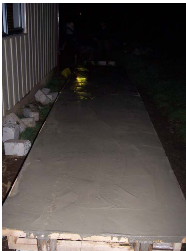
Fotografía 4.4 Superficie de losa afinada.
