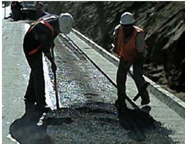
**Figura N° 47.** En la fotografía se pueden observar trabajadores con dos tipos de vestimenta de seguridad. Al lado izquierdo un obrero con arnés, y al derecho uno con peto reflectante.
