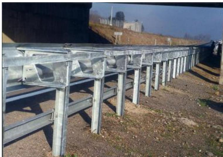
**Fotografía Nº 22.** Sistema Semirígido, viga triple onda con separador y riel inferior.
