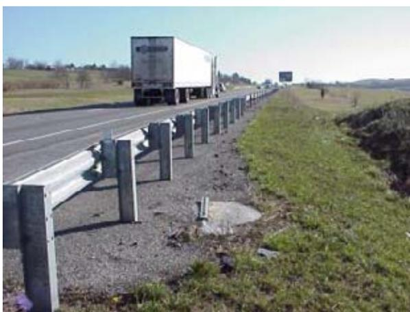
**Fotografía N° 21.** Sistema Semirígido, barrera con perfil “W”
