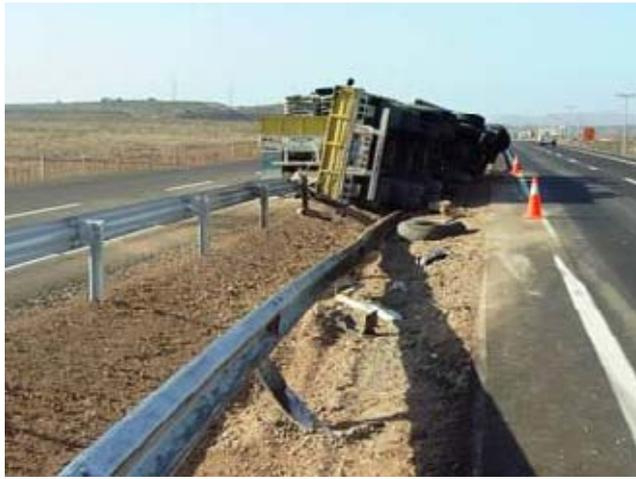
**Fotografía N° 29.** Barrera traspasada por vehículo pesado, doble calzada
