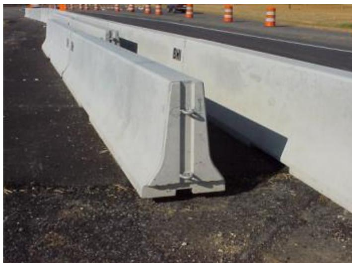
**Fotografía N° 26.** Barrera de hormigón provisoria.
