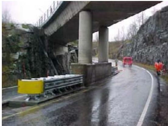
**Fotografía N° 39.** Sistema Quadguard.
