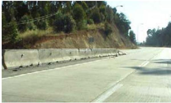
**Fotografía Nº 33.** Barrera rígida con terminal abatido.
