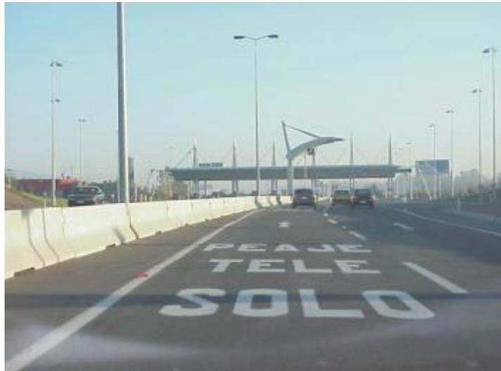
**Fotografía N° 23.** Sistema rígido, barrera de hormigón
