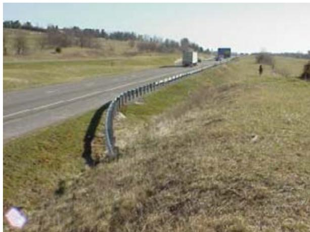
**Fotografía N° 34.** Barrera con terminal enterrado en un talud de corte.
