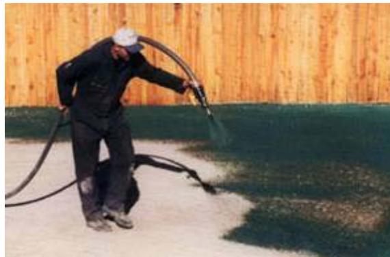
Fotografía N° 48: Aplicación de la Hidrosiembra en taludes
