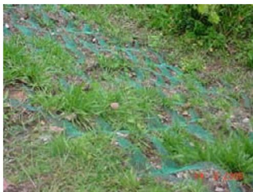
**Fotografía N° 43:** Talud protegido con malla de HDPE y Material Vegetal
