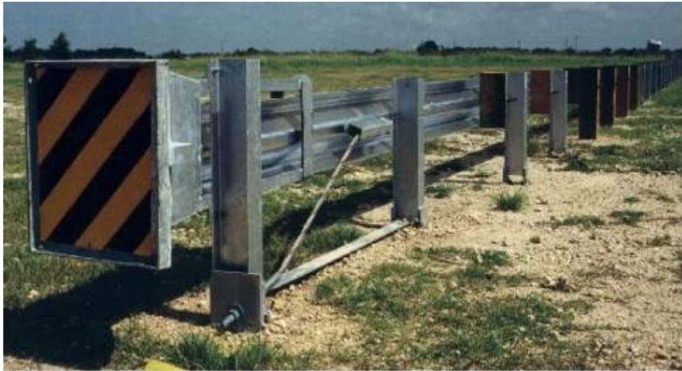
**Fotografía N° 35.** Terminal atenuador del tipo extrusor.
