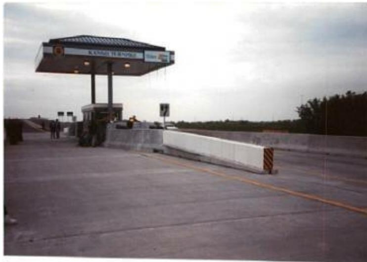
**Fotografía N° 37** Terminal de Módulo de Extensión de Impacto Dinámico.
