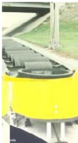
**Fotografía N°40.** Atenuador de Bajo Mantenimiento (LMA).
