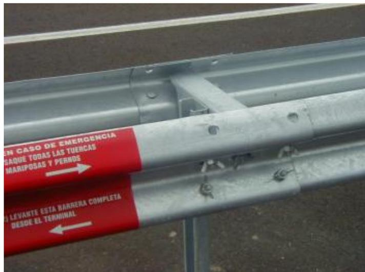
**Fotografía N° 24.** Barrera removible, perfil "W"
