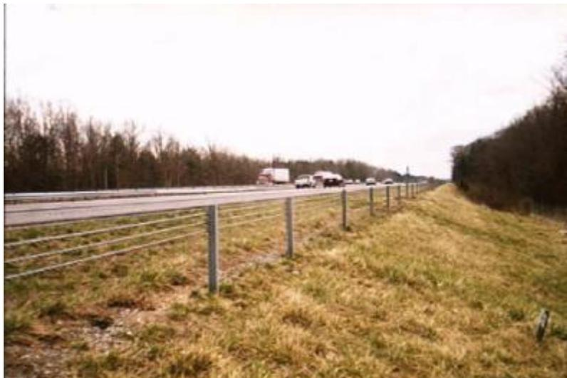
**Fotografía Nº 19.** Sistema flexible, Cables de acero.
