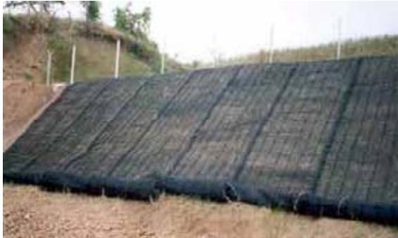
**Figura N° 51: Aplicación de geosintético en taludes**
