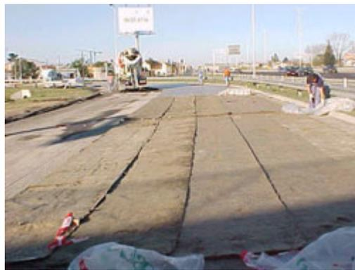
La contracción Plástica por evaporación acelerada del contenido de humedad en el hormigón puede producir agrietamientos con profundidades que van
