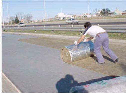
Es esencial la colocación de estas mantas para evitar la evaporación acelerada del contenido de humedad existente en el Hormigón recién colocado, y evitar así un proceso de contracción plástica que provocaría agrietamientos superficiales en nuestro pavimento.
