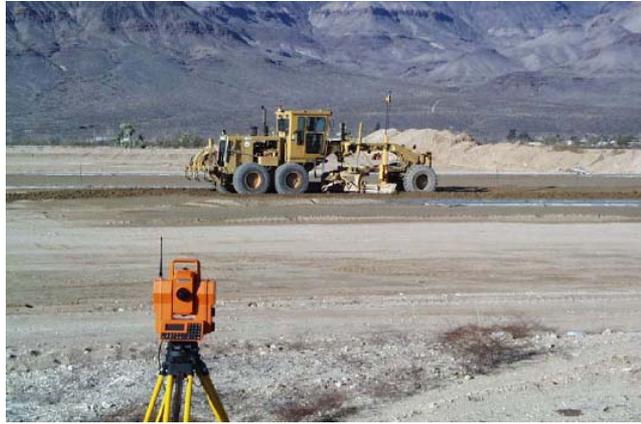
**Fig. N° 37. Sistema de seguimiento automático para Motoniveladora. Control tridimensional.**
