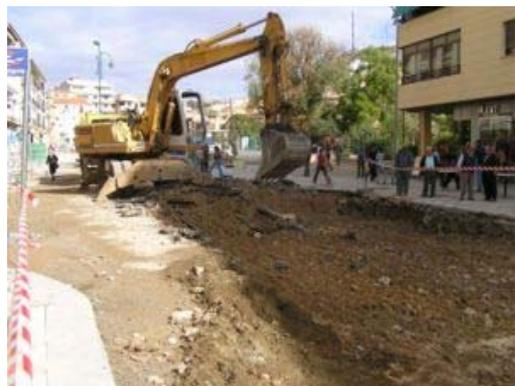
**Fig. N° 15. Pala Excavadora montada sobre orugas.**
