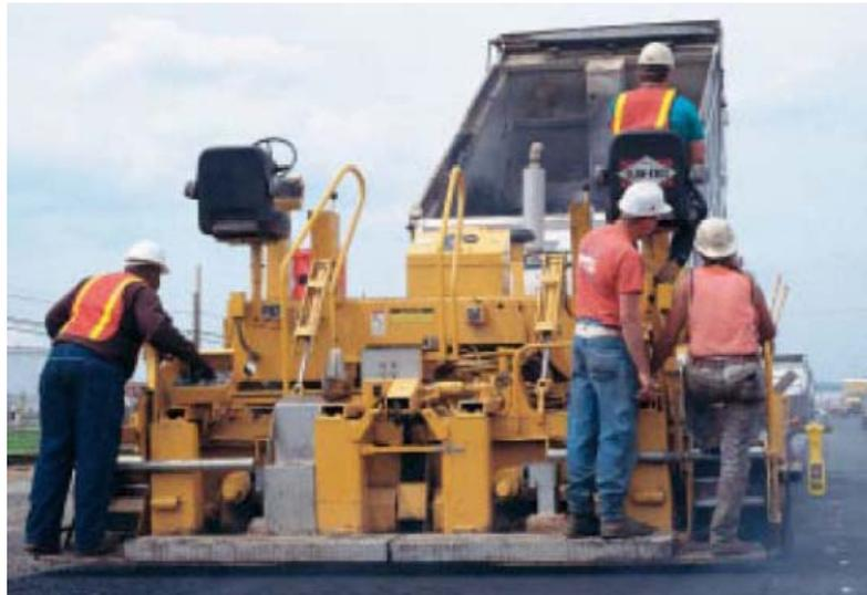
**Fig. N° 28. Asfaltadota con Sistema Ultrasonido con referencia a la pasada anterior.**
