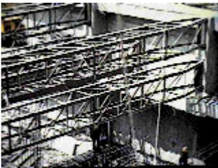
Excavación apuntalada con Vigas Metálicas
