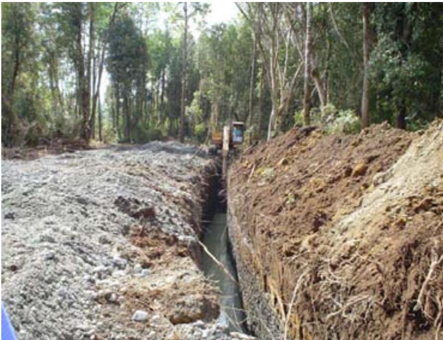
3) Evidentemente no se observa además ningún tipo de puntales para evitar el desmoronamiento del terreno. Aunque para este tipo de trabajos no se necesita transitar dentro de la excavación sino que solamente fuera de ella. Pero en más de una ocasión el jefe a cargo de la obra se acercaba bastante a las orillas de dicha excavación para verificar e inspeccionar la labor realizada, todo esto lleva a suponer una falta de conciencia frente a los hechos.
