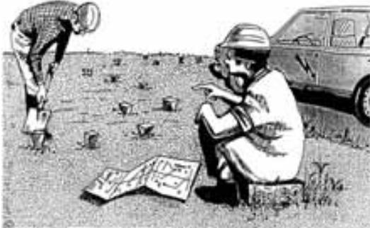
**Localización de cables eléctricos enterrados, según un plano, y marcado de su posición.**
