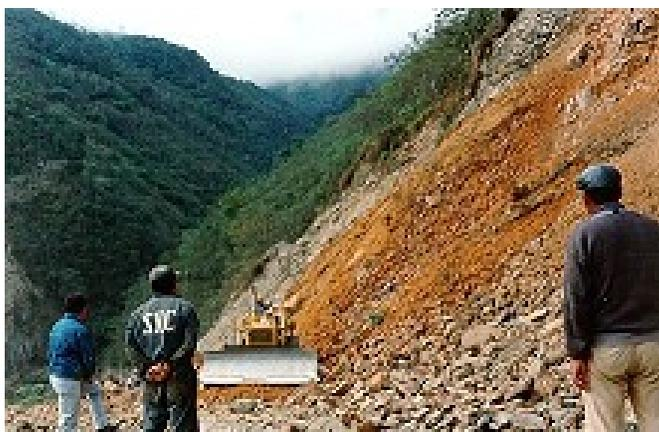
Es el desplazamiento lento y progresivo de una porción de terreno, más o menos en el mismo sentido de la pendiente, que puede ser producido por diferentes factores como la erosión del terreno o filtraciones de agua.
