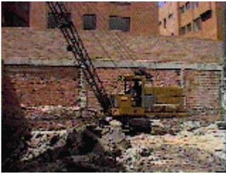
Equipo utilizado para la excavación de muros pantalla
