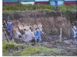
Perfeccionamiento del Talud de excavación
