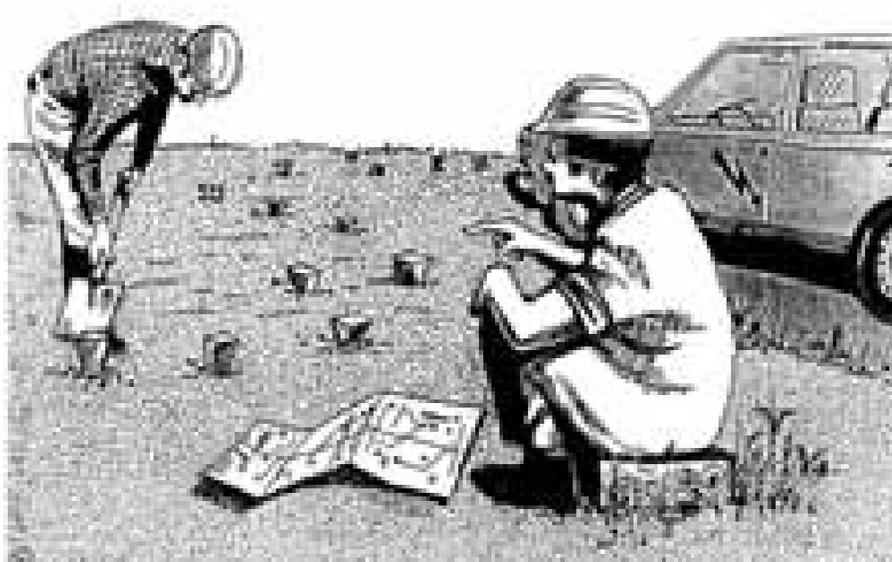
**Localización de cables eléctricos enterrados, según un plano, y marcado de su posición.**
