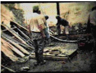
Fundición del muro pantalla con un tubo trompa de elefante
