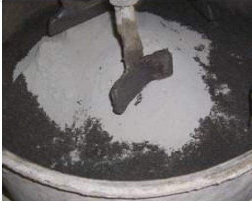
Fotografía N° 1: Betonera con arena y cemento.
