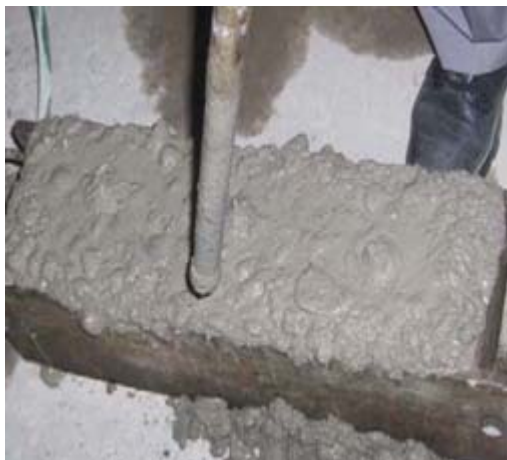
Fotografías N° 4: Vibrado de moldes prismáticos mediante vibrador eléctrico .
