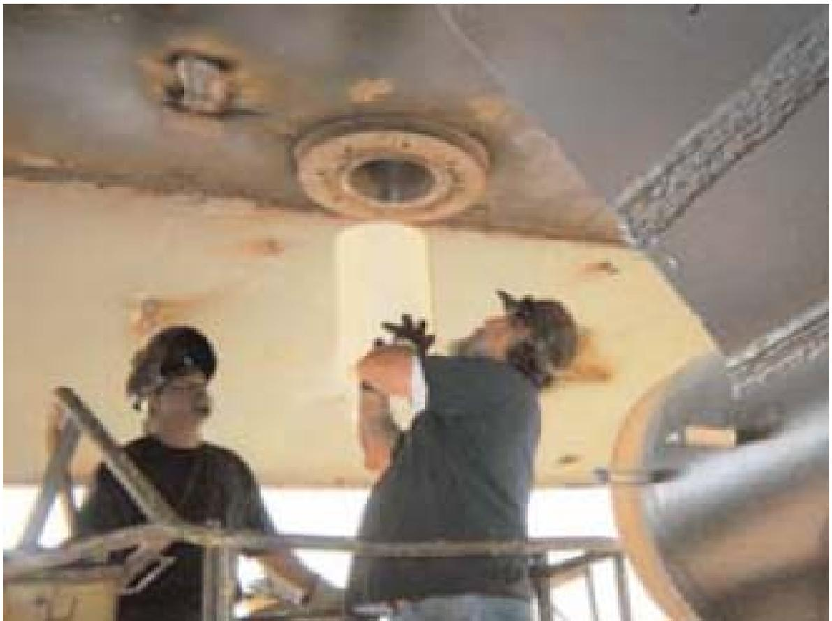
La instalación de los cojinetes thordon es muy sencilla, se utilizan las técnicas de enfriamiento tomando en cuenta sus características y a demás las medidas de mecanizado.
