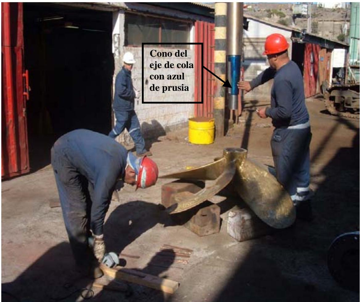
En esta fotografía, se aprecia el eje suspendido sobre la hélice, preparado para la realización de la prueba. Se observa que el trabajador se encuentra colocando las tintas reveladoras del contacto entre los 2 elementos. (azul de prusia)
