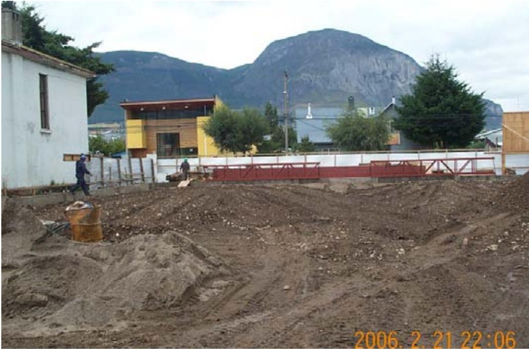
FOTO 06: Muestra la faena de relleno bajo radier. El cual fue sometido a ensayo proctor modificado y a ensayos de medición de densidad in situ, todo por un laboratorio autorizado, quien emitió su informe respectivo. Lográndose las densidades solicitadas en las especificaciones técnicas. El procedimiento a seguir se encontraban claramente establecidos en el PPI.
