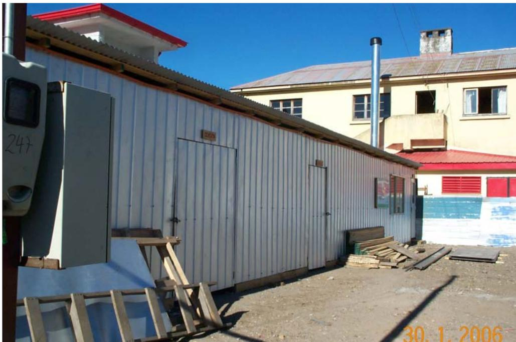
FOTO 03: Muestra parte de la instalación de faenas de la obra. Todo lo que corresponde a la oficina de terreno, pañol y bodega de cemento, cada una identificada claramente. Este punto es muy importante, ya que se debe cumplir con lo establecido en las Bases Administrativas del contrato, y permite además, mantener un orden en terreno.
