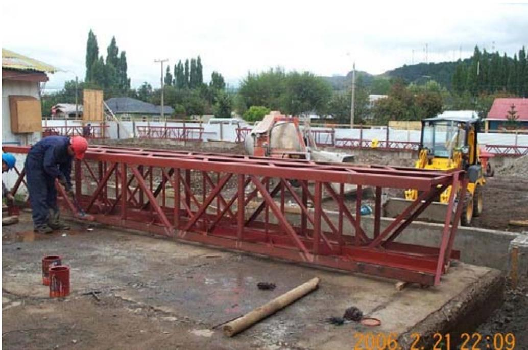
FOTO 09: Muestra la fabricación de la estructura metálica (foto pilares). Para lo cual se entregó un croquis detallado de cada elemento a fabricar al soldador (calificado) a cargo de dicha faena, quién, ante cualquier duda recurría al profesional residente. Dicho procedimiento específico (PE) y PPI se encuentran en el anexo N° 4
