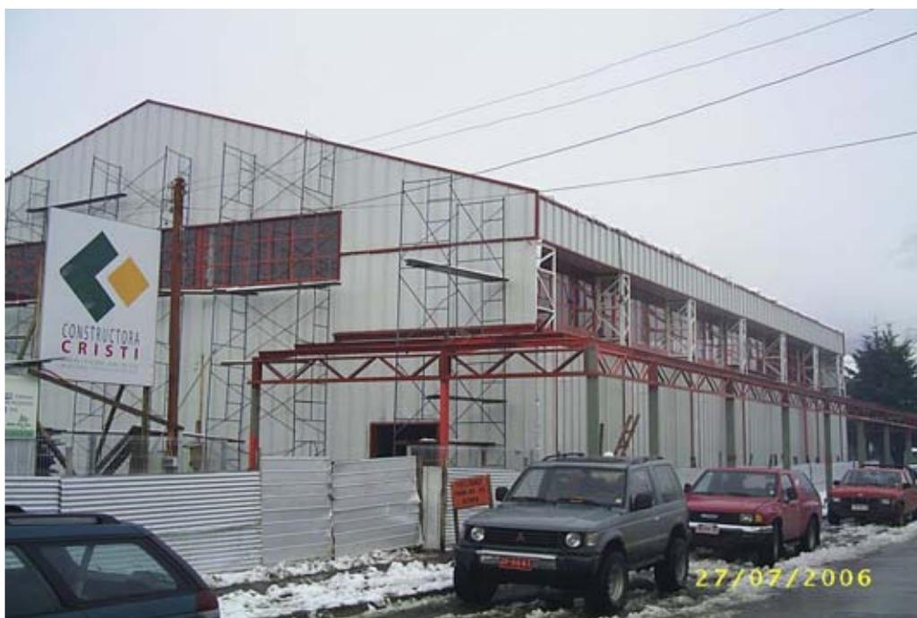
FOTO 18: Muestra los andamios que se utilizaron durante la ejecución del revestimiento exterior. Cabe mencionar que avanzar con velocidad no implica disminuir la supervisión y cumplimiento de la normativa de prevención de riesgos.
