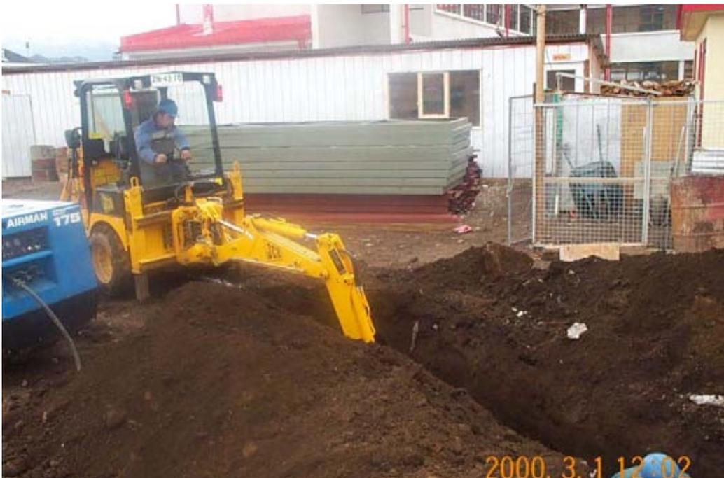
FOTO 07: Muestra la excavación de la zanja para la colocación de la red de alcantarillado mediante una “minirretroexcavadora”. Cabe mencionar que dada las condiciones del terreno se tuvo que romper roca mediante martillos demoledores que funcionaban mediante aire comprimido.
