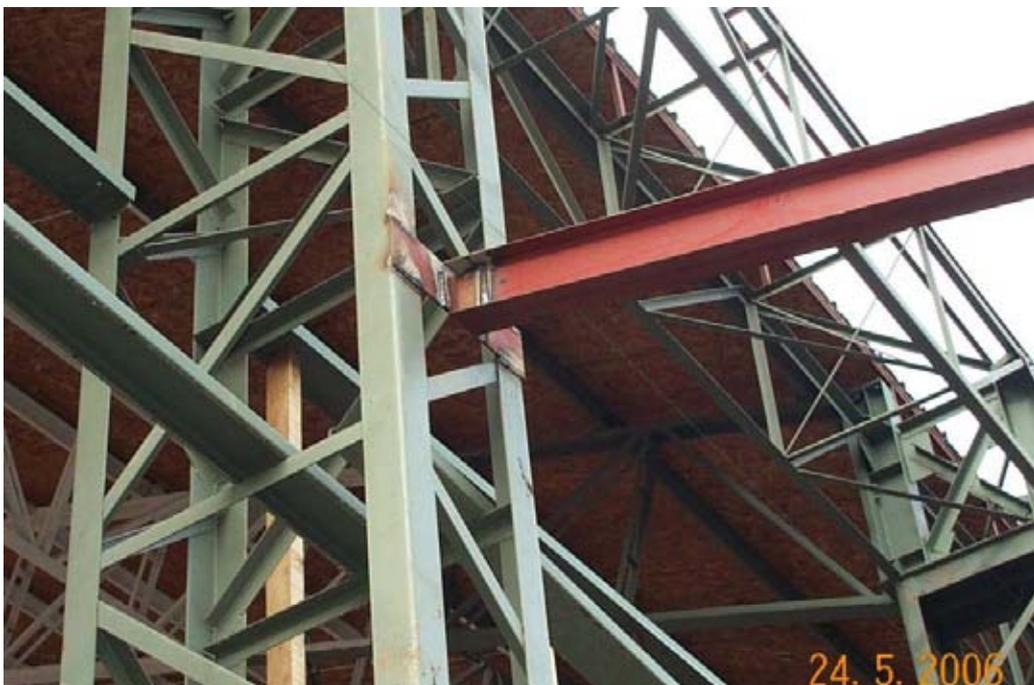
FOTO 13: muestra la unión de la estructura de techumbre del corredor a la estructura del gimnasio. Todos los flanches, tanto soldados como apernados, se entregaban en detalle para ser perforados y/o cortados según fuere el caso. Las soldaduras fueron supervisadas visualmente debiendo cumplir los parámetros establecidos en los PPI.
