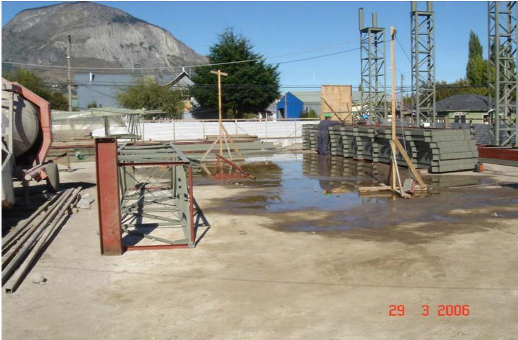
FOTO 10: Muestra los pilares montados, lo que se hizo utilizando un camión grúa. Esta fotografía muestra además, el acopio ordenado de la estructura metálica en la cancha, lo que muestra una adecuada programación y supervisión de la obra.
