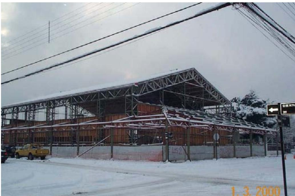
FOTO 15: Muestra la obra durante el período de nieve. Cabe mencionar que tanto los hormigones como la cubierta se encontraban ejecutados al momento de comenzar dicho período. Pero se había comenzado la ejecución del revestimiento interior el cual fue protegido exteriormente con polietileno de 0,2mm de espesor e interiormente con aceite linaza. El galpón permitió preparar en su interior todos los elementos metálicos para luego instalarlos una vez que la temperatura exterior superara los 5°C.
