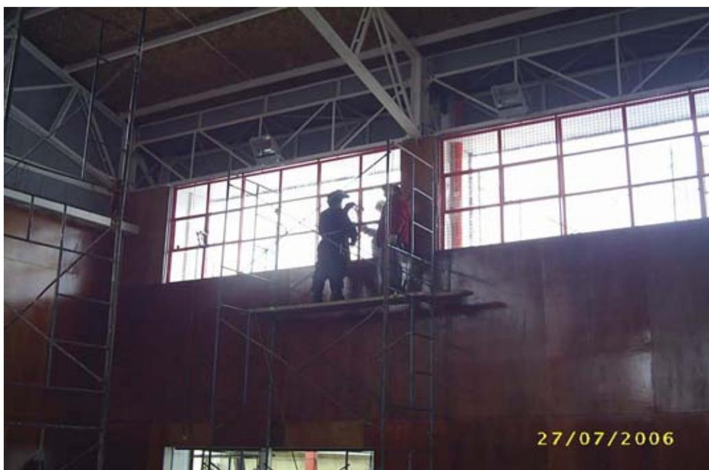
FOTO 19: Muestra la ejecución de las ventanas. Su geometría y disposición se entregó en forma clara y detallada mediante un croquis al soldador a cargo de la ejecución. Lo que fue chequeado mediante los PPI y ejecutado cumpliendo las normas de seguridad.
