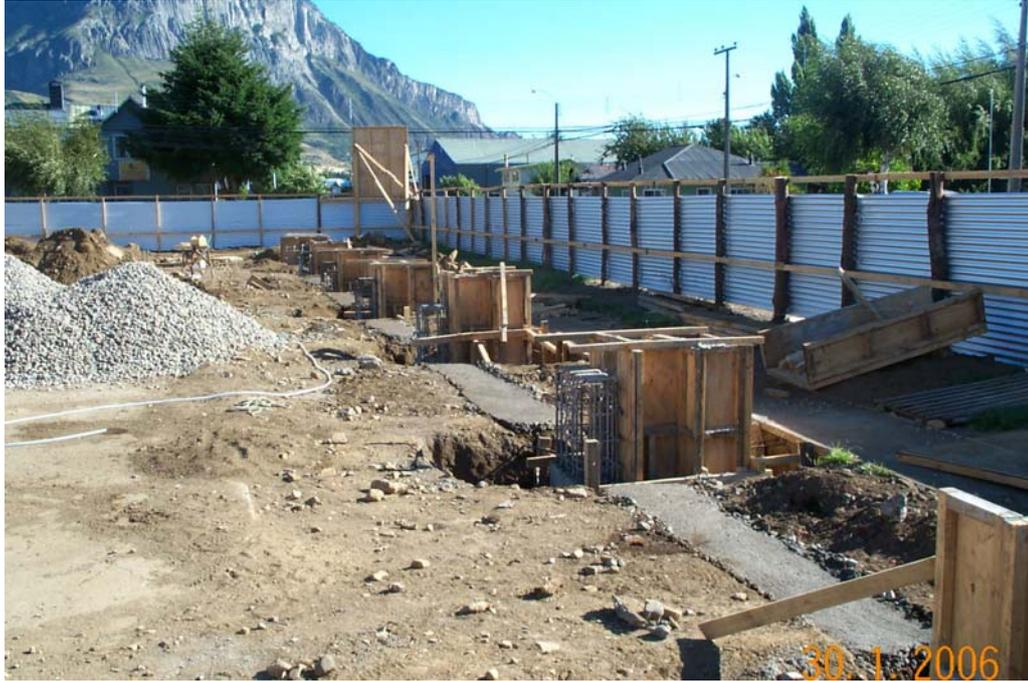
FOTO 02: Muestra las fundaciones del SUM. El procedimiento y PPI aplicados en esta partida se encuentra en el anexo N° 1. Cabe mencionar que antes de comenzar con la faena de hormigonado se contaba con el ensayo de granulometría y dosificaciones de hormigones requeridos en esta faena (anexo N° 2). Lo anterior permite tener en terreno las dosificaciones, las cuales deben ser claramente indicadas y visibles al operador (pegadas en la betonera), de acuerdo al volumen especificado.
