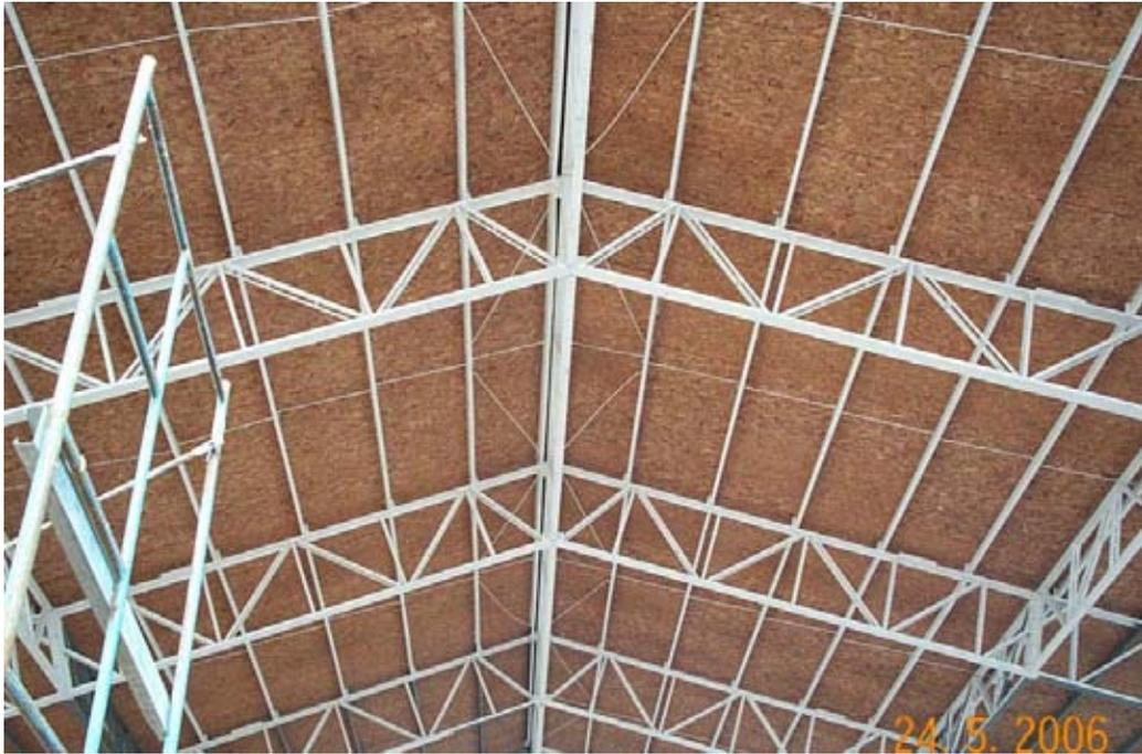
FOTO 14: Muestra colocación de la pintura intumescente sobre la estructura, la cual debía cumplir con un F-60. Lo anterior fue infeccionado a través de los PPI, y por una la empresa externa que emitió el certificado en el cual indicaba que cumplía con el espesor solicitado.
