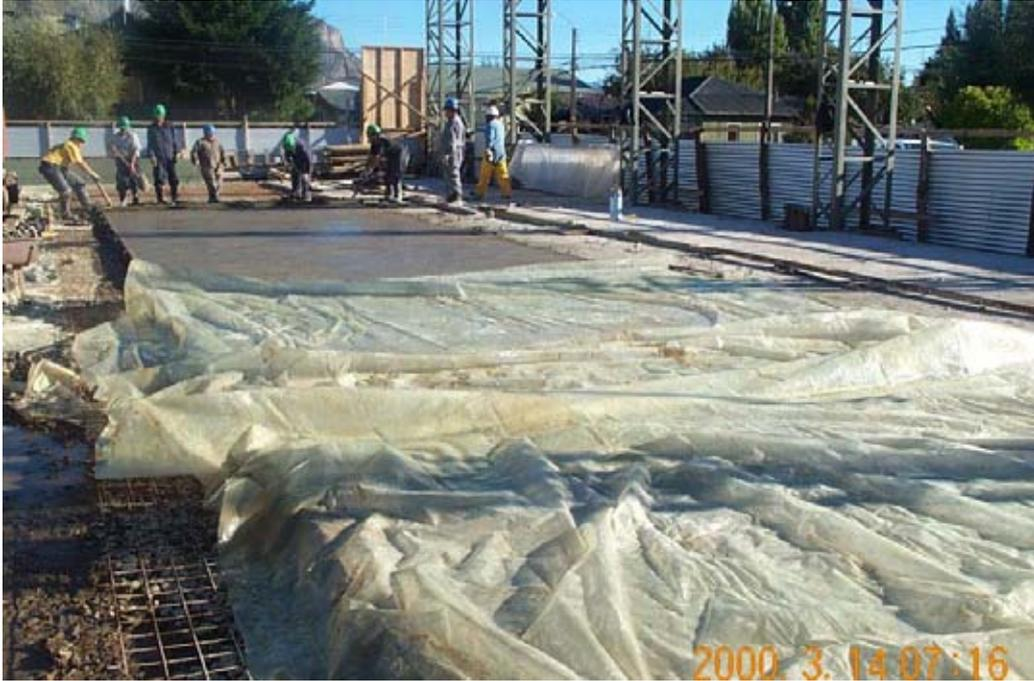
FOTO 08: Muestra la ejecución del radier de la cancha. El cual se ejecutó mediante fajas longitudinales de 4mts de ancho. En este punto se fue muy riguroso en la inspección en cuanto al curado del hormigón y control de niveles, debido a que sobre el radier se debería colocar el pavimento deportivo. Durante su ejecución se obtuvieron muestras de hormigón, las cuales fueron ensayadas en un laboratorio autorizado por el MOP. La cartilla de inspección se encuentra en el anexo N° 3.
