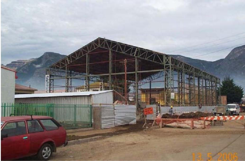
FOTO 12: Muestra un corte de media calzada para conectar la red de alcantarillado con el colector. Además se comenzó con la excavación de las zapatas exteriores que recibirían el corredor techado (exterior). Lo anterior para generar en una sola instancia las molestias a los peatones. Se aprecia también que la estructura se encuentra montada en su totalidad y se comenzó la ejecución del encamisado.
