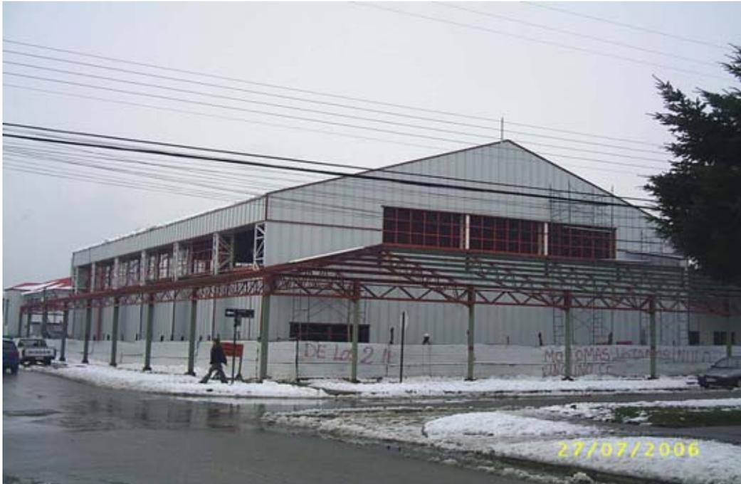
FOTO 16: Muestra que llegada las planchas correspondientes al revestimiento exterior, se comenzó con la instalación de éste, de tal forma de cerrar completamente el gimnasio y así proteger el recinto y trabajar con mayor tranquilidad. Para ello se entregaron croquis de instalación y disposición de las planchas a las cuadrillas de carpinteros.
