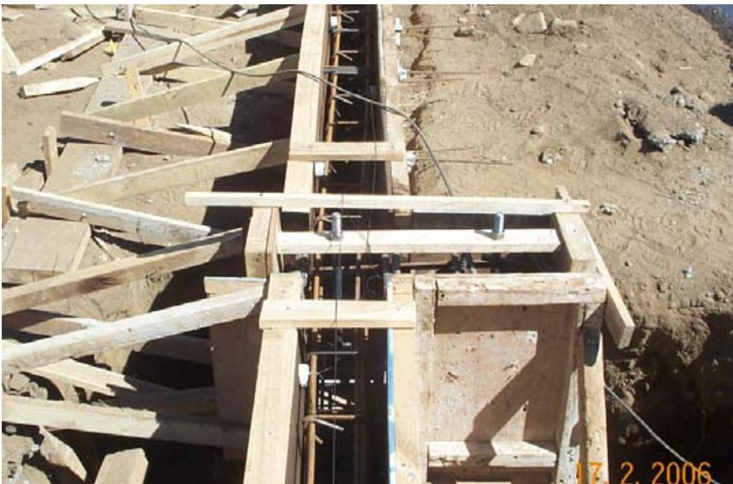
FOTO 05: Muestra el moldaje de las vigas de fundación. En ella también se aprecia los pernos limpios y a eje de las columnas de viento. Los requisitos para aprobar la inspección estaban indicados en la cartilla de control (PPI).
