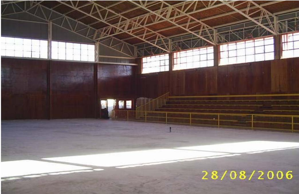
FOTO 20: Muestra el SUM prácticamente terminado, faltando solamente la instalación del piso deportivo, previa ejecución de un retape para recibir dicho pavimento, cual fue instalado por el fabricante.
