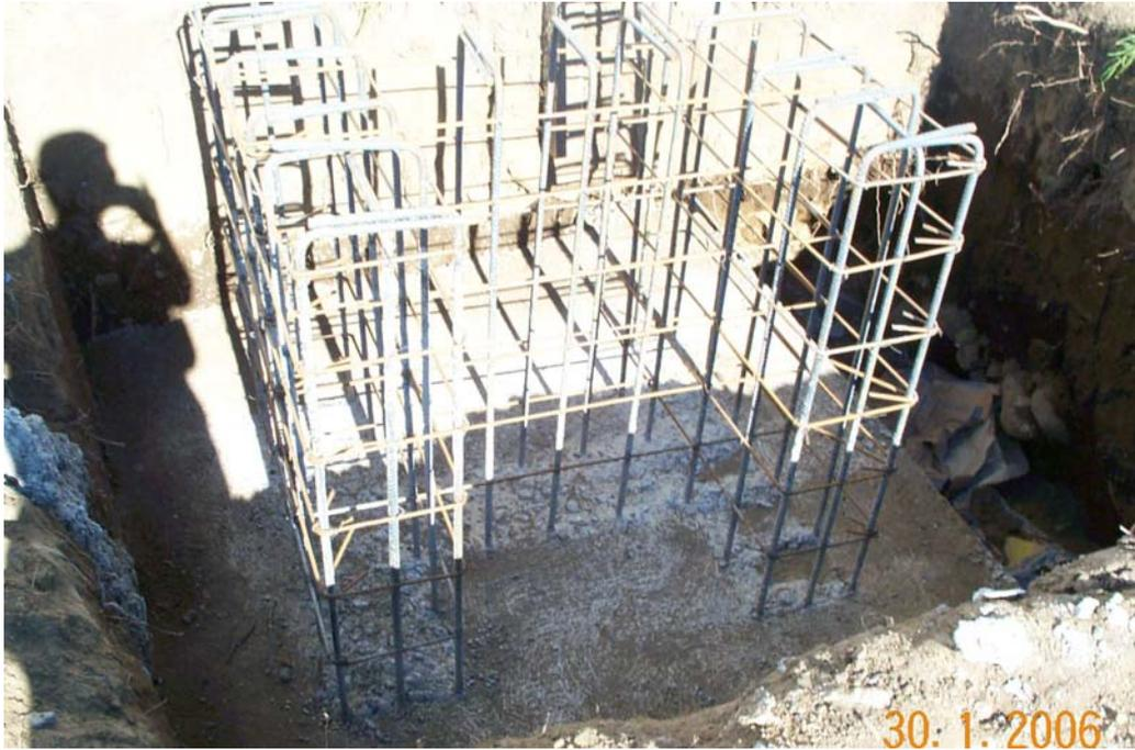
FOTO 04: Muestra la armadura de una zapata, en ella se aprecia claramente la prolijidad con la que se armó, como también la limpieza de la armadura. Para ejecutar esta zapata el enfierrador contaba con un croquis detallado de la disposición de los fierros, dicho croquis se encontraba siempre a la vista (debidamente plastificado). Lo anterior está claramente indicado en el anexo N° 1
