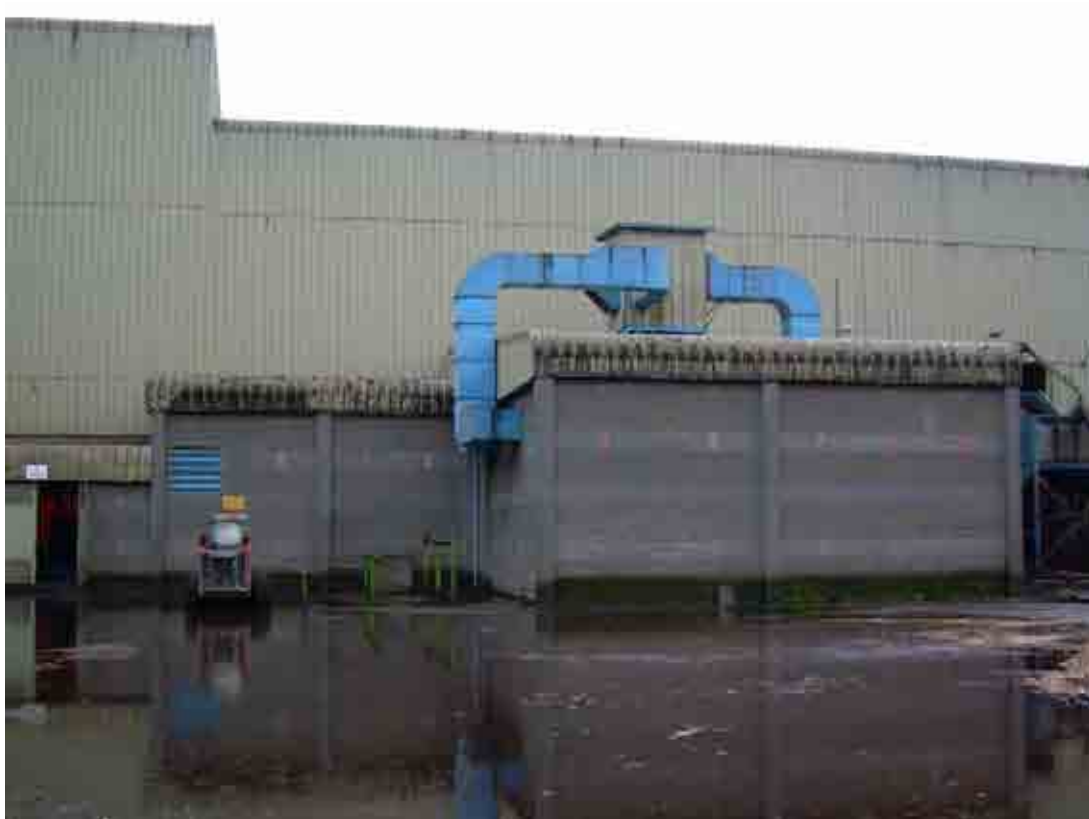
Figura 1.2. Vista del exterior de la sala eléctrica.
