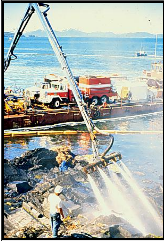
Limpieza en playas por chorros de alta presión. Figura 10.
