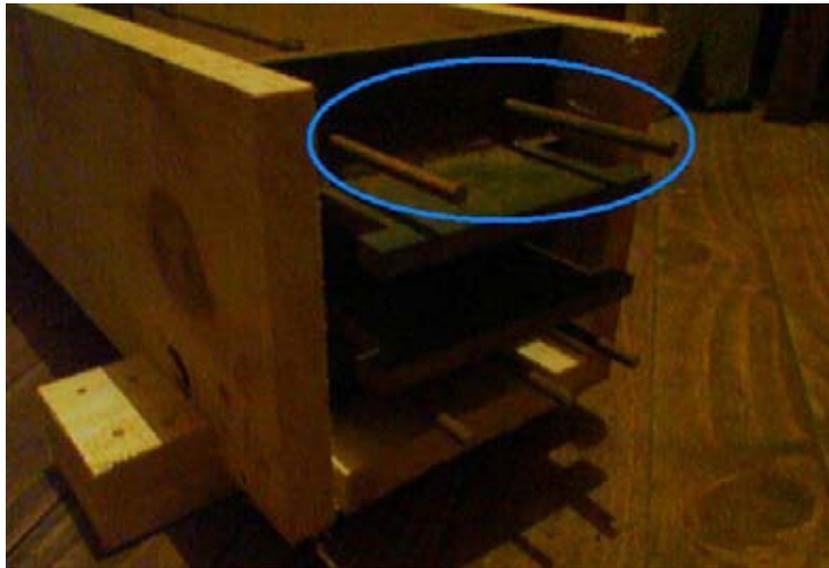
*Figura 6.3.2.1: Armaduras Soldadas entre ellas.*
