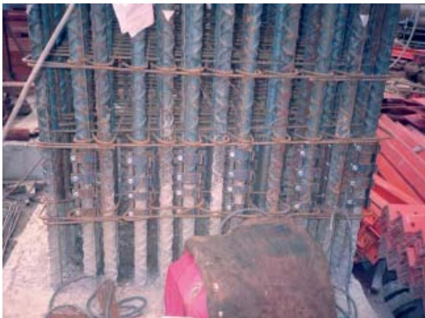
*Figura 2.3.2.6.2: Aplicación empalme Speed Sleeve.*
