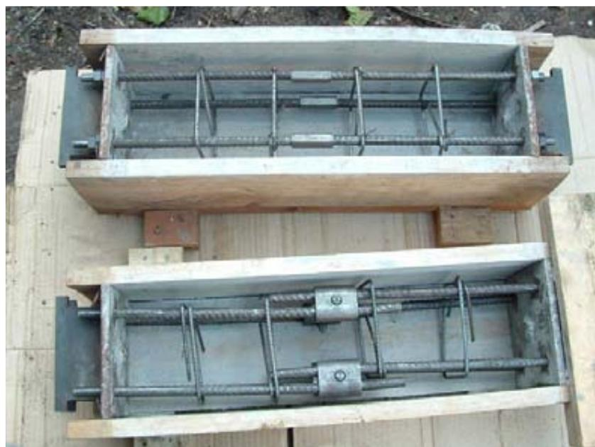
**Figura 4.5.2:** *Moldajes con empalmes mecánicos para hormigonar.*
