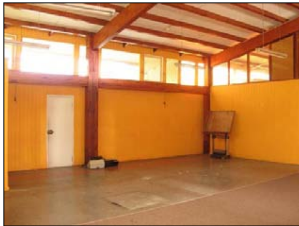
Figura 79: Fotografía de sala piloto, Zona A.
