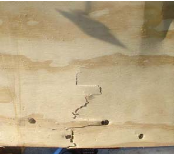
Viga 3 (VC 9): (Falla del contrachapado en el tercio central de la luz de ensayo)
