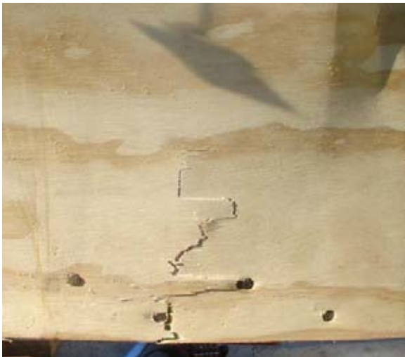
Viga 3 (VC 9): (Falla del contrachapado en el tercio central de la luz de ensayo)
