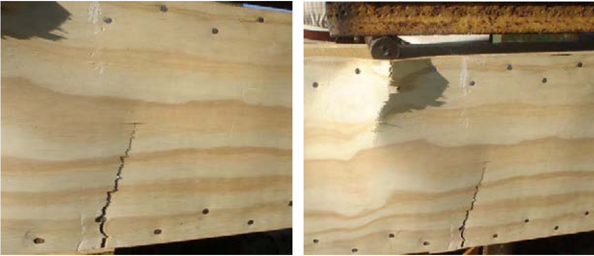
Viga 2 (VC 9): (Falla del contrachapado en el tercio central de la luz de ensayo)
