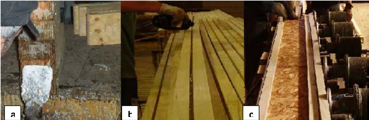
Figura 13. a.- Aplicación del adhesivo con espátula, b.- Dosificación manual del adhesivo en las alas, c.- Prensado de viga.
