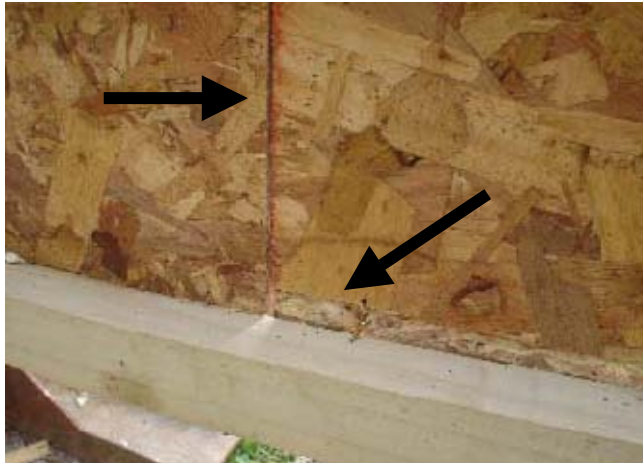
Figura 16. Separación de alma del ala, cercana a la unión de almas.
