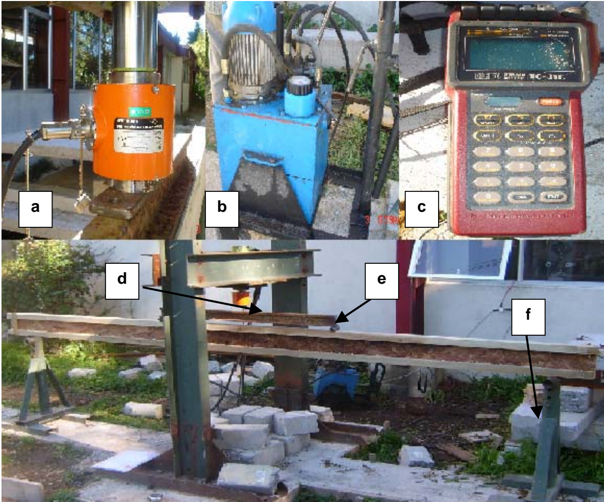
Figura 5. Marco de carga. a.- Pistón hidráulico, b.- Compresor, c.- Medidor electrónico de carga, d.- Pieza metálica de carga, e.- Rodillo de transmisión de carga, f.- Apoyo metálico para las vigas
