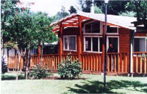
Sector de Oficinas de Administración.
