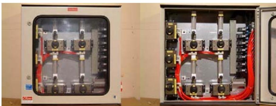
Fig.14 Central de Regulación de Oxígeno, marca CFlow
