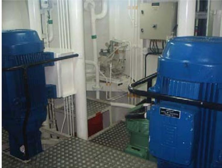
Bombas centrífugas de recirculación (Bb y Eb)
