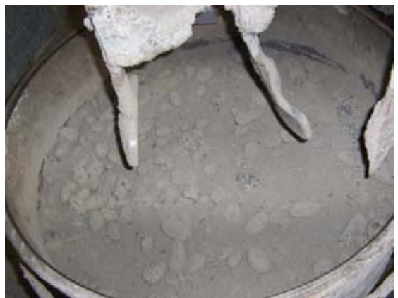
Betonera con arena, cemento y grava
