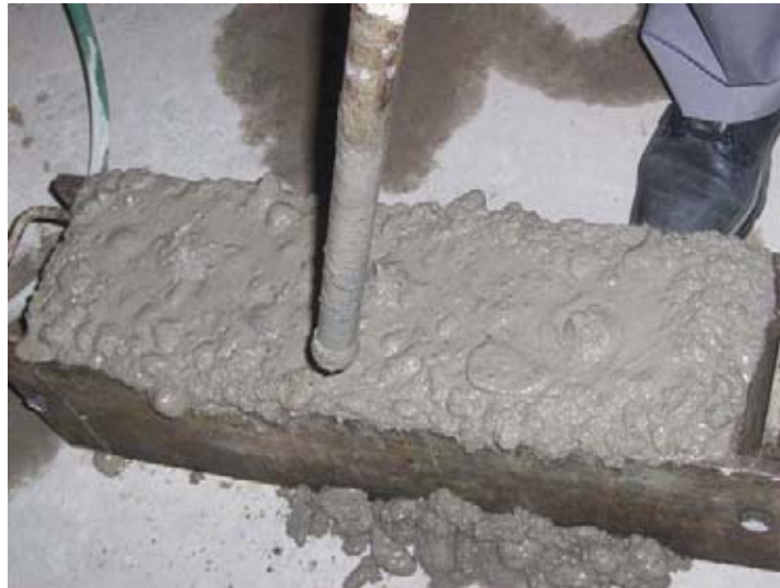
Compactación con vibrador
