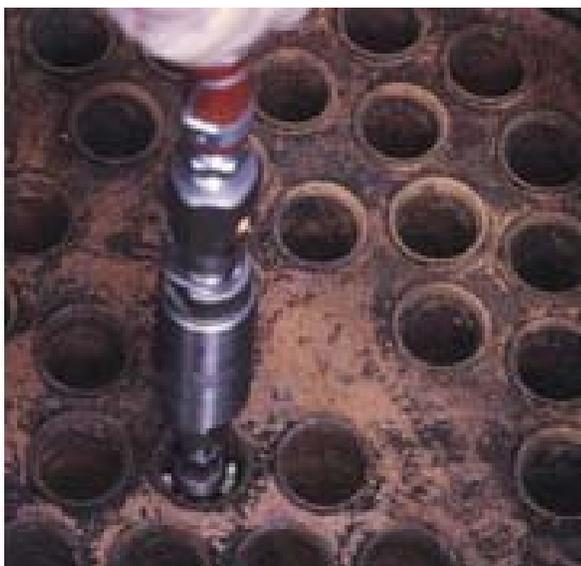
**Limpieza Mecánica de Lados de Agua de Caldera Auxiliar**
