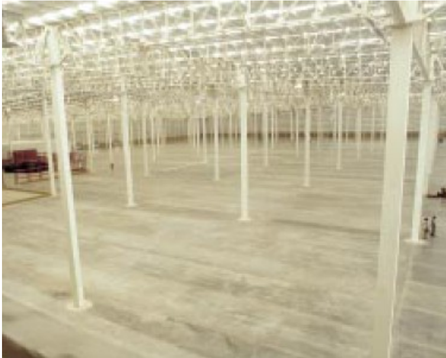
Fig. 3. Centro de Distribución Nestlé, Santiago de Chile 30.330m 2 Pavimento industrial superplano (Postensado)
