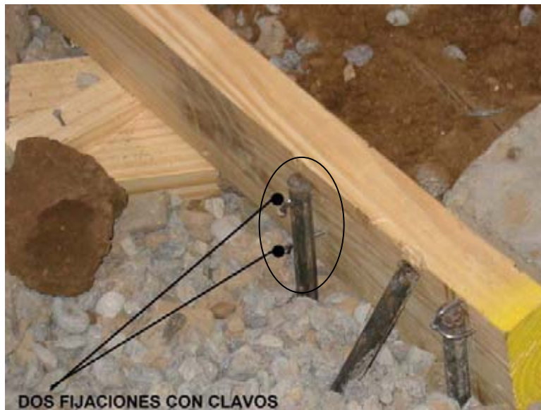
Estacas (Importante para afirmar el moldaje)
