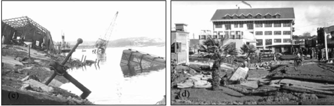
**Figura 4.4** Daños producidos por fallas de suelos en Puerto Montt en el terremoto de 1960, (a) y (b) licuefacción de suelos de relleno en la costanera, (c) deslizamiento del terreno en el puerto, (d) hundimiento de una estatua por pérdida de la capacidad de soporte (Fotos de Kurt Grassau).
