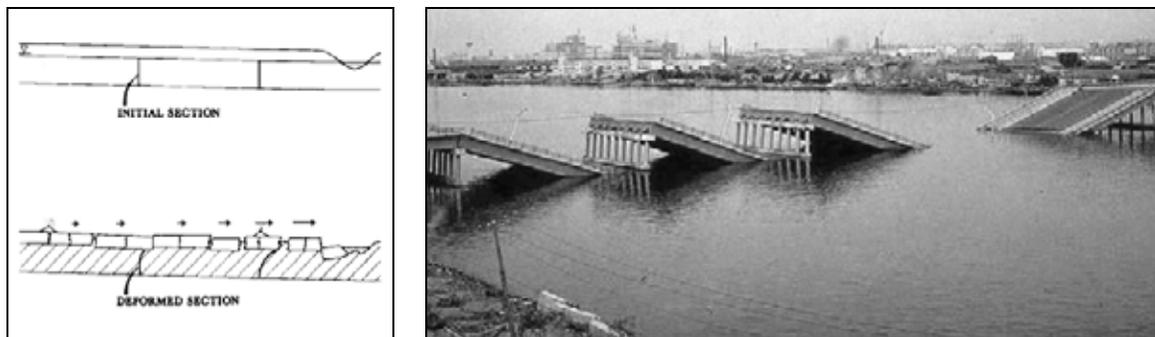
**Figura 4.16** Diagrama de un desplazamiento lateral (Greene et al., 1994) y desplazamiento lateral en el puente Showa en el terremoto de Niigata de 1964 (Kramer y Stewart, 2004).
