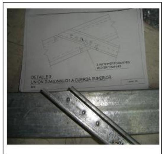
**Figura (6.14): perforación con tornillos autoperforantes punta broca**
