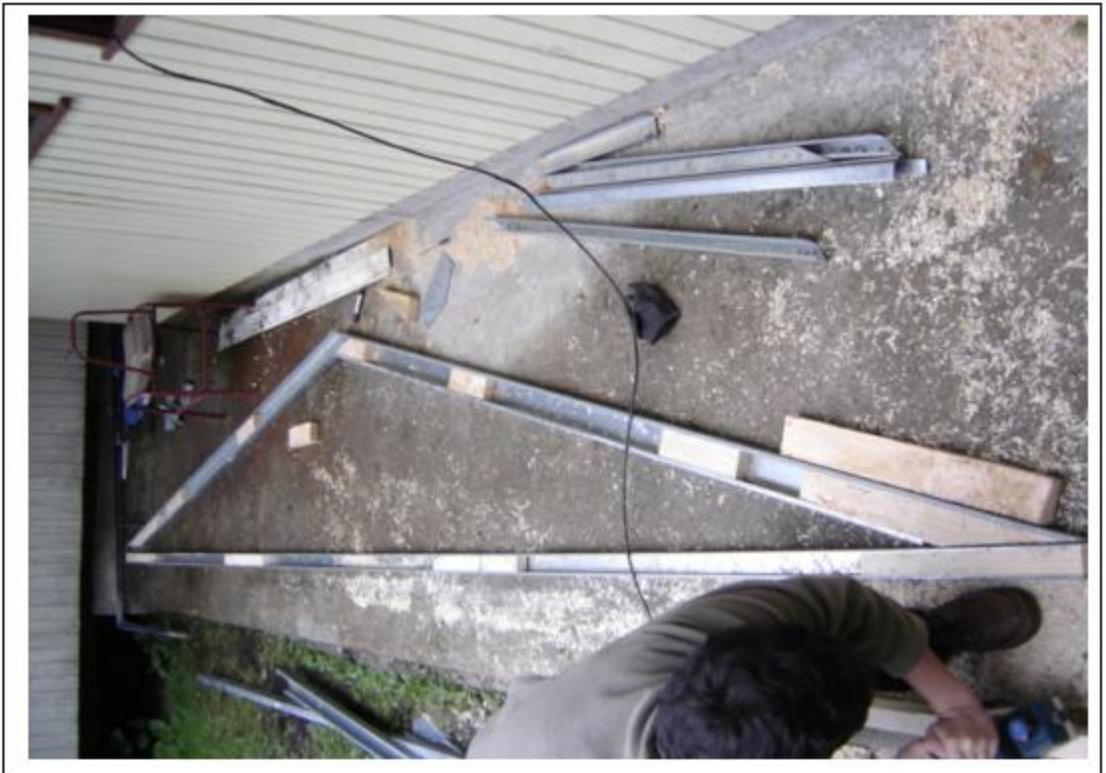
**Figura (6.5): Fabricación refuerzos de madera.**
