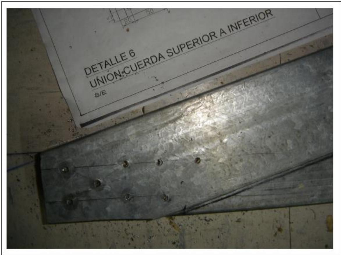
**Figura (6.15): perforaciones con tornillos autoperforantes punta broca**
