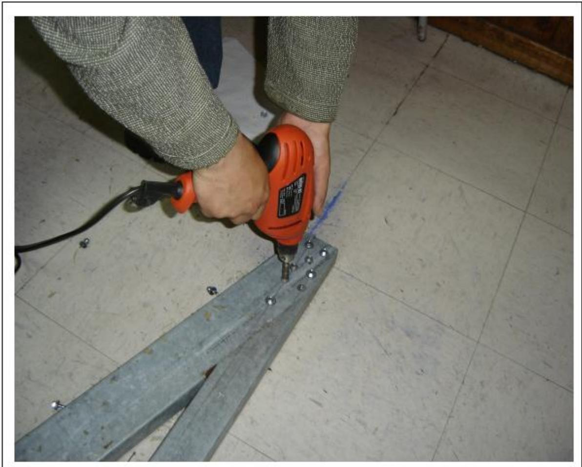
**Figura (6.15): instalación de tornillos punta aguda**
