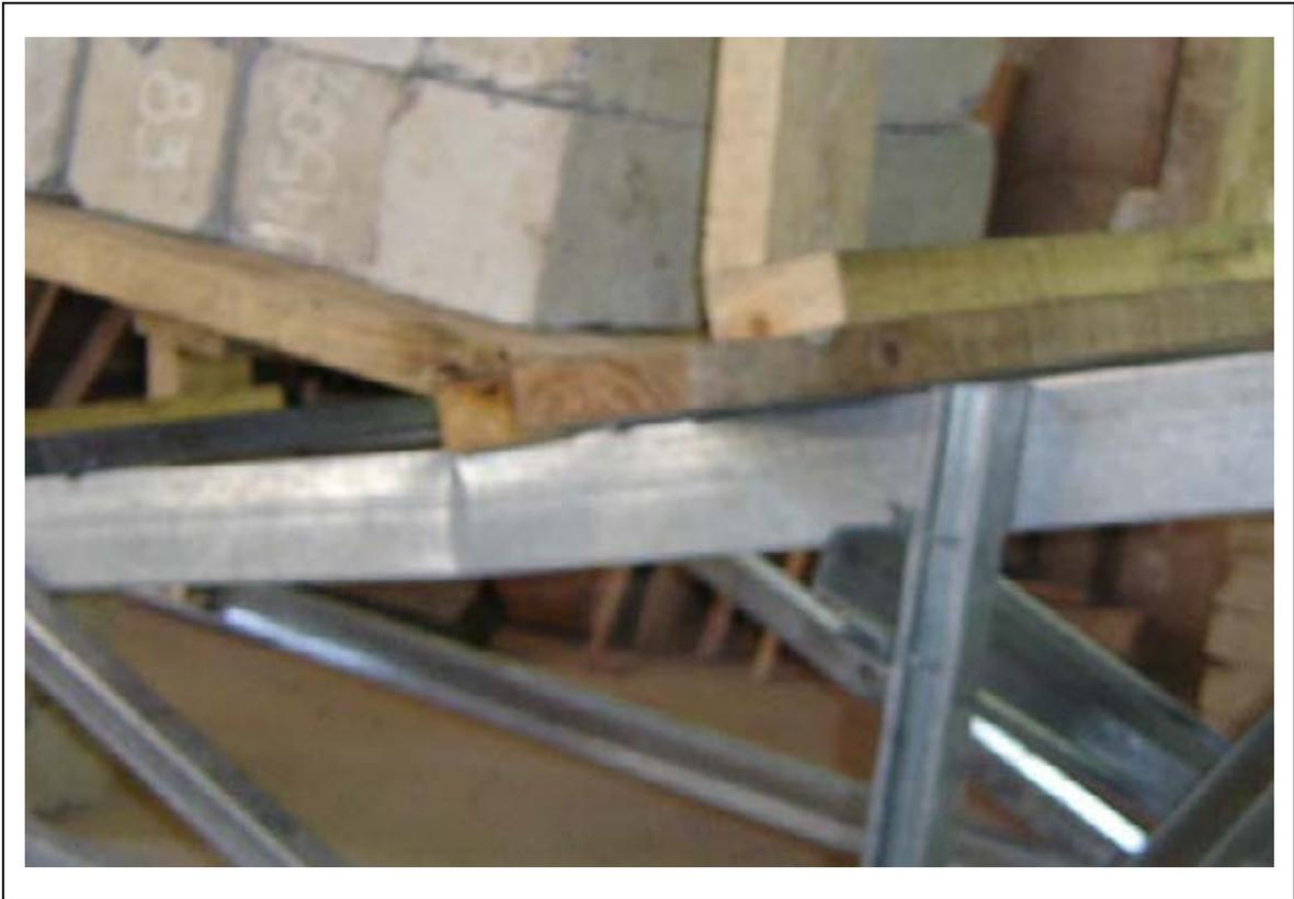
Figura (8.4): falla visible momentos antes del colapso
