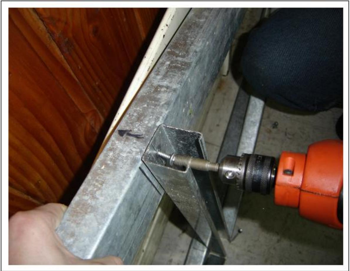
Figura (6.15): instalación de tornillos punta aguda
