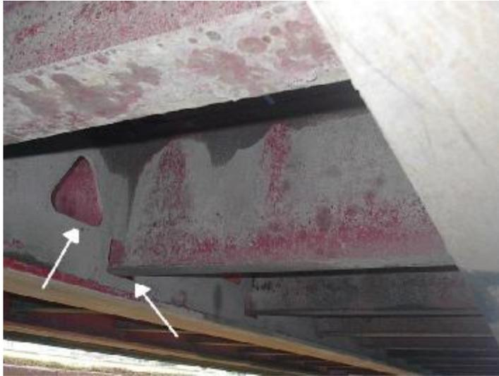
Figura 20 – Cortes en Vigas Mastras en SR. actuales.
