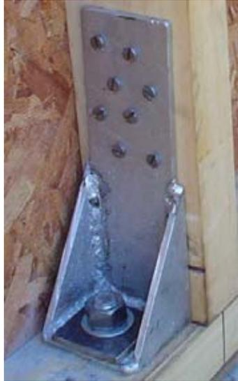
Figura A.3. Conector metálico que une el segundo pie derecho
