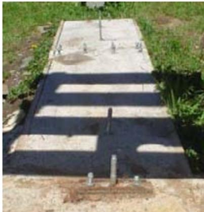
Figura 7.13. Sistema de anclaje del panel
