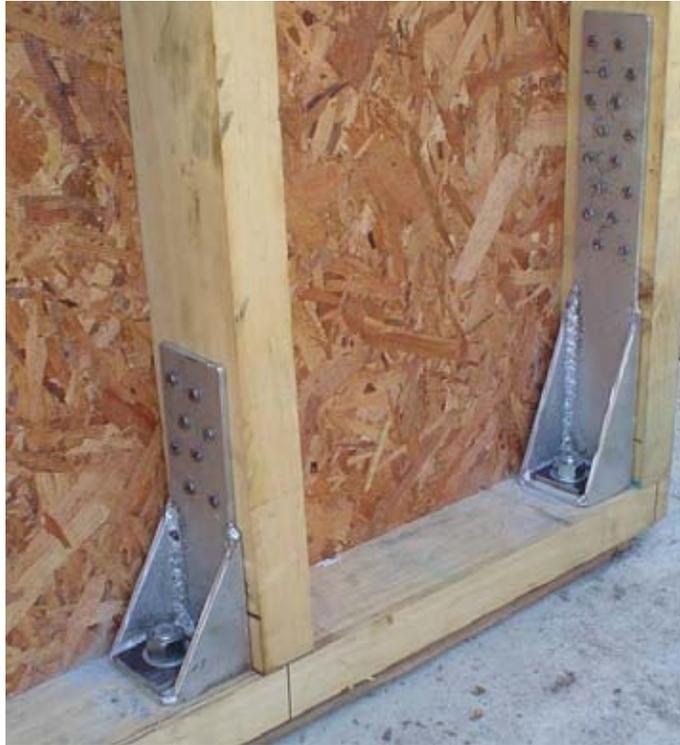
Figura 5.2 conectores metálicos
