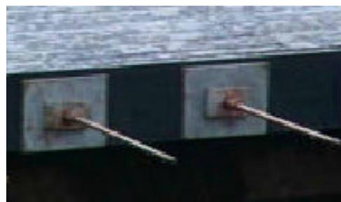
**Fig. 2-12: Anclaje con placa de apoyo.**
