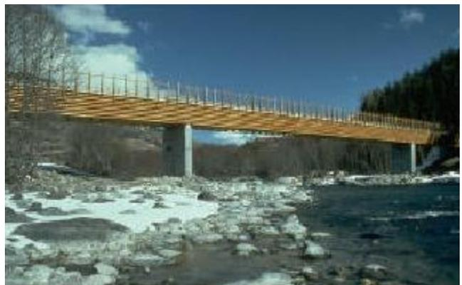
Fig. 1-1: Viga de madera laminada, puente vehicular.
