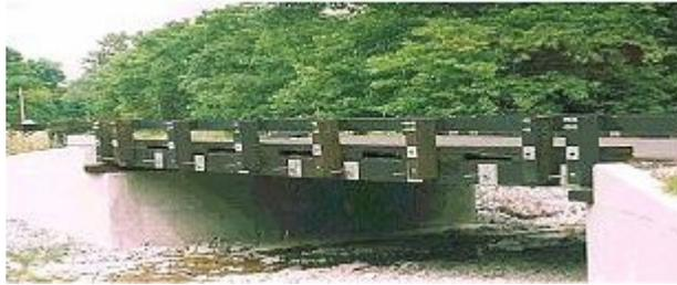
Puente de tablero de madera postensado de 11 metros de largo (USA).
