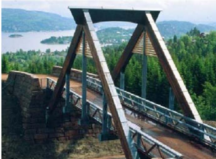
**Fig. 1-8: Puente vehicular tipo King Post.**
