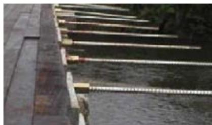
Fig. 2-9: Barras de post-tensado.
