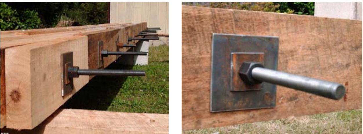
Fig. 3-6: Barras de tensado, placas de apoyo, placas de anclaje y tuercas hexagonales.
