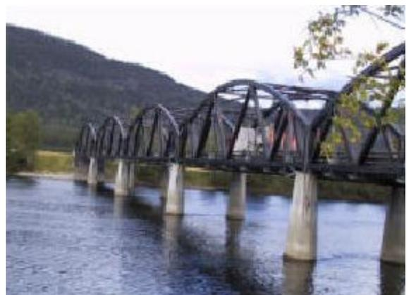
**Fig. 1-6: Puente vehicular reticulado.**
