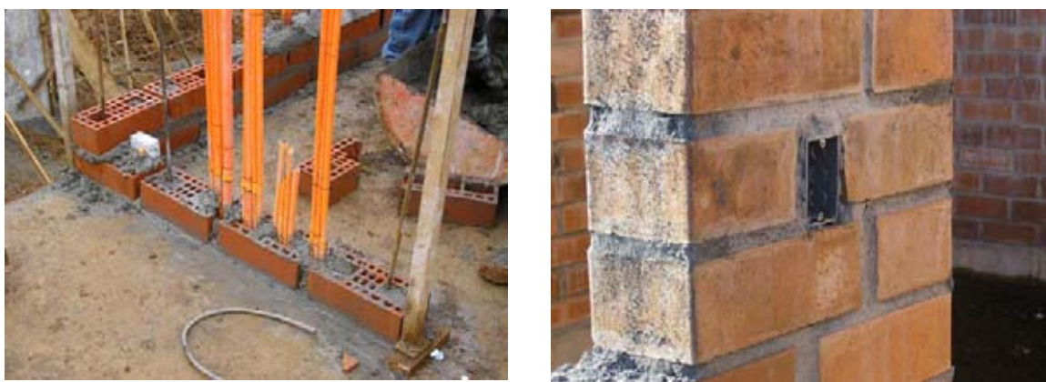
Figura 18: instalación eléctrica en albañilería
