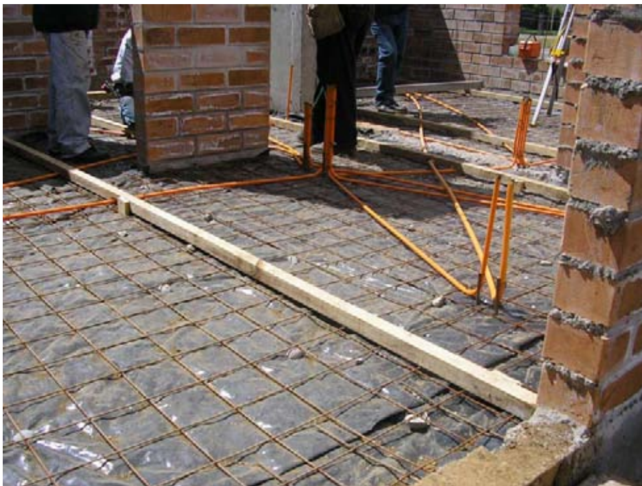
Figura 17: canalización eléctrica en el radier
