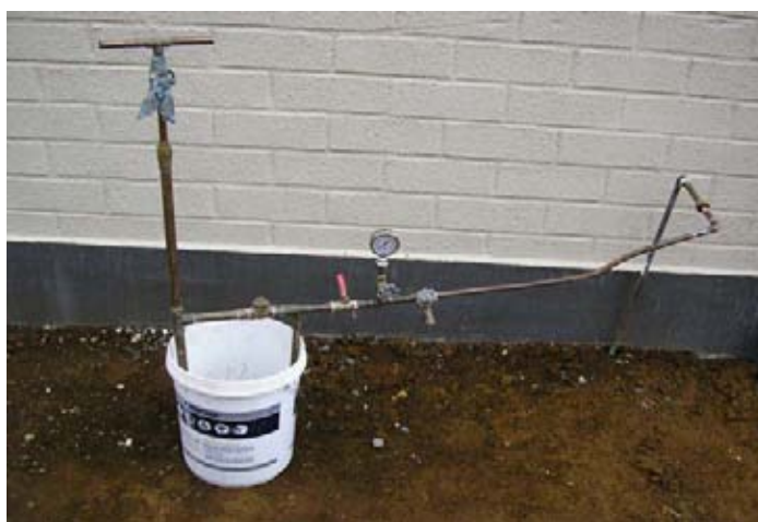
Figura 21: prueba presión hidráulica sistema agua potable
