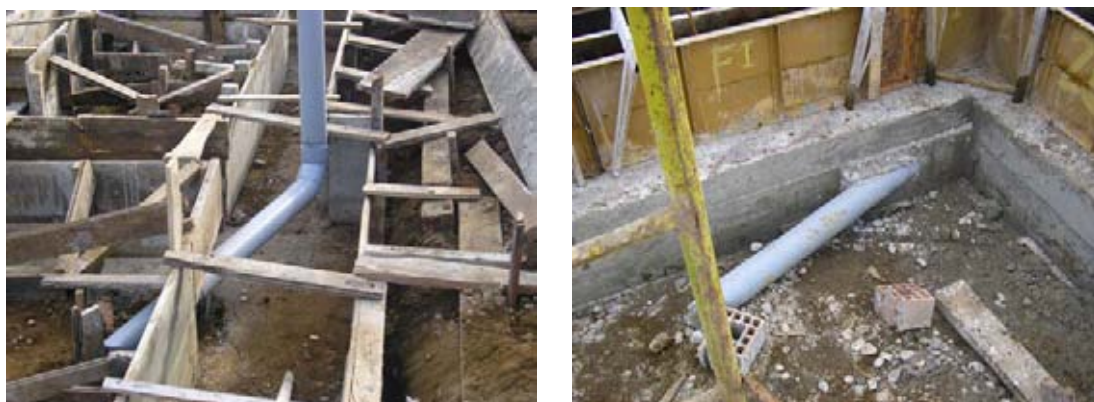
Figura 12: tuberías en moldaje de fundaciones
