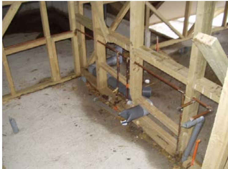
Figura 10: distribución tuberías en estructura de madera
