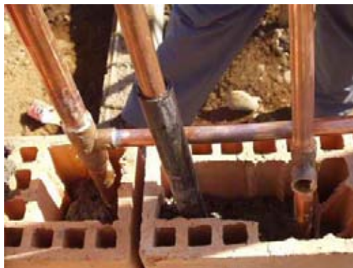
Figura 8: distribución de tuberías en albañilería
