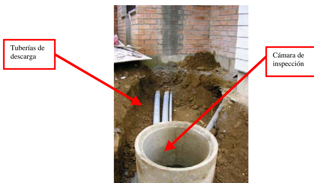
Figura 11: conexión tuberías a la cámara de inspección
