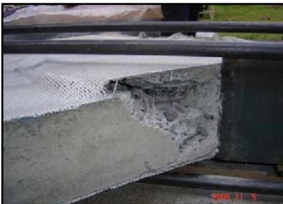
**Fig. 5.24** Vista apoyo murete N° 3. Se aprecia el daño significativo que sufrió el apoyo al momento del colapso de este.
