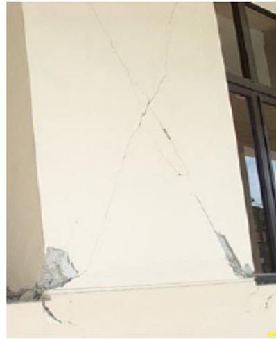
**Figura 2.5** Típica fisura de corte diagonal, en ambos sentidos, después de un sismo.
