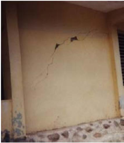
**Figura 2.4** Fisura de corte diagonal.
