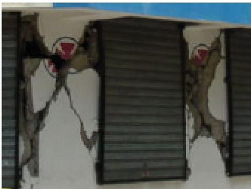
**Figura 2.6** Muros de hormigón con grandes daños, debido a la poca cuantía de acero.
