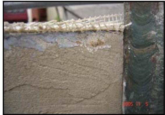
**Fig. 5.23** Vista apoyo contrario murete N° 2. Al igual que en el otro apoyo, no se detectan mayores daños en los apoyos.
