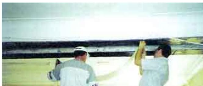
2. Nivelar las vigas, la saturación de las bandas de carbono y su posterior colocación.
