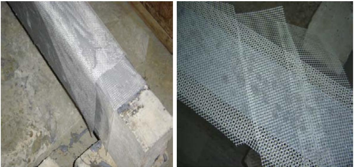
*Foto1- 2 Aplicación de la malla de fibra de vidrio en una viga sobre la resina de impregnación*
