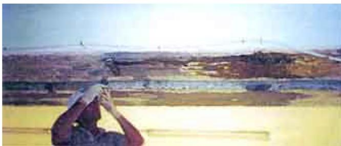
*1. Una vez saneadas y reconstruidas las vigas, se procede a una imprimación previa.*
