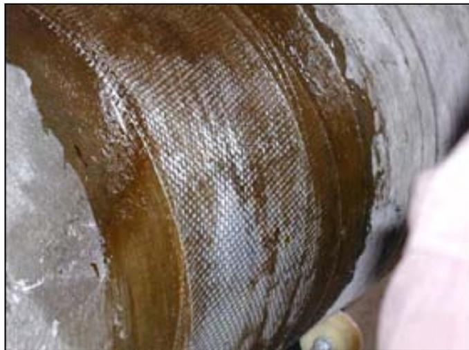
**Figura 4.42** Proceso de saturación (Kvaerner, 2005)
