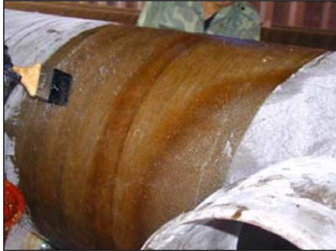
**Figura 4.37** Mat saturado en resina (Kvaerner, 2005)
