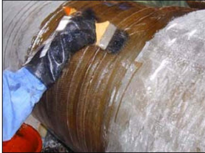
**Figura 4.45** Saturación del woven cloth (Kvaerner, 2005)
