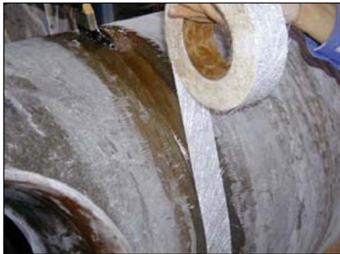
**Figura 4.31** Unión de la barrera de corrosión (Kvaerner, 2005)
