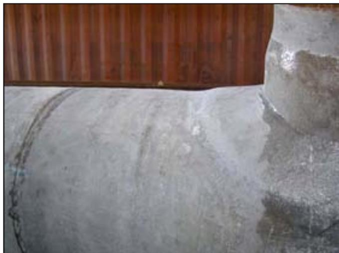
**Figura 4.34** Barrera de corrosión finalizada (Kvaerner, 2005)
