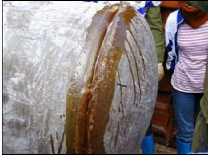
**Figura 4.27** Aplicación de roving alrededor de la unión (Kvaerner, 2005)
