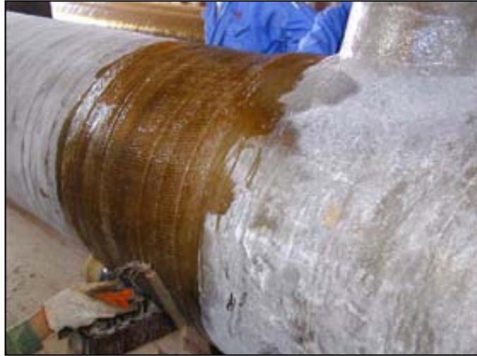
**Figura 4.43** Eliminación de burbujas (Kvaerner, 2005)
