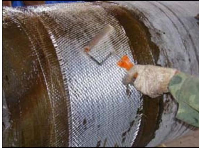
**Figura 4.40** Aplicación de rodillo metálico (Kvaerner, 2005)
