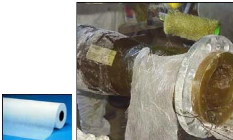
**Figura 2.16** Fibra de vidrio tipo Velo superficial. Foto izquierda (Vetrotex, 2001), foto derecha (tomada por la autora)
