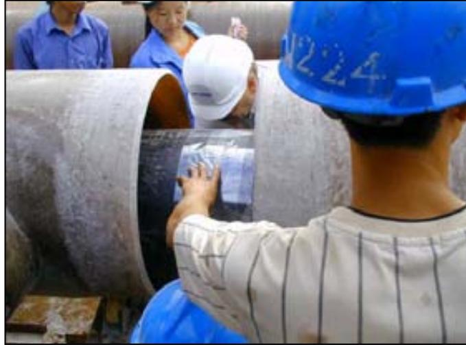
**Figura 4.17** Colocación lámina de poliéster (Kvaerner, 2005)
