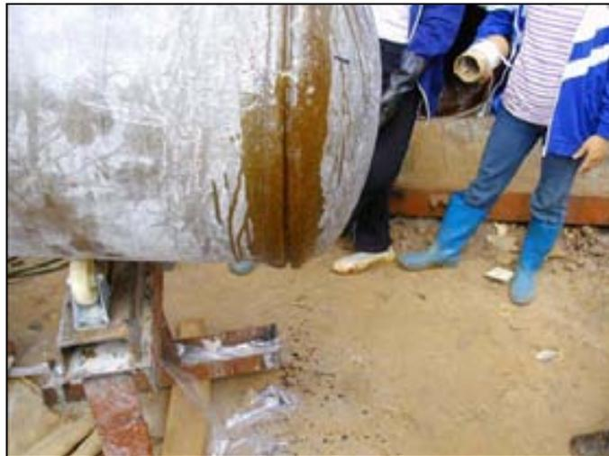
**Figura 4.28** Aplicación de resina (Kvaerner, 2005)
