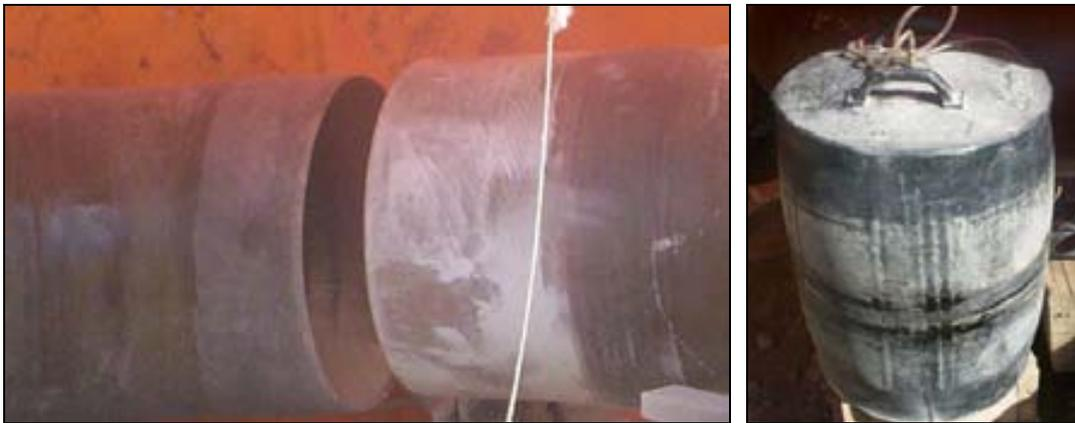
**Figura 5.1** Preparación de la unión y molde interior (Fotos tomadas por la autora)
