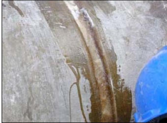
**Figura 4.32** Impregnación del mat en resina (Kvaerner, 2005)
