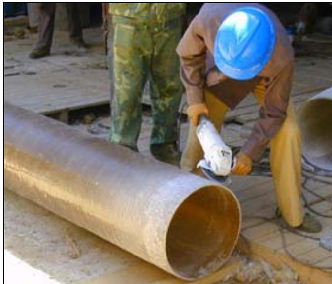
**Figura 4.11** Preparación de una unión PN1 (Kvaerner, 2005)
