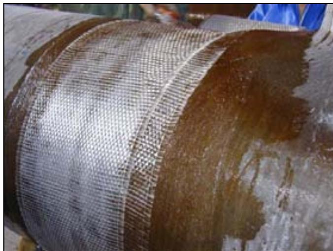
**Figura 4.38** Aplicación del woven roving (Kvaerner, 2005)
