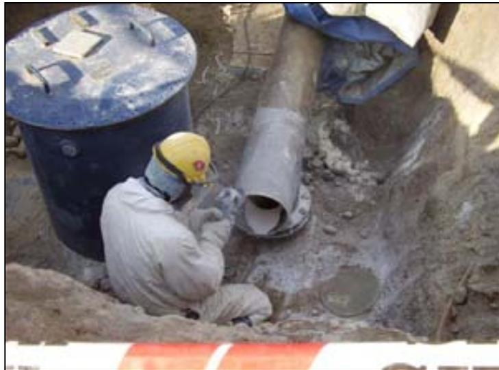
**Figura 5.44** Preparación de la tubería (Fotos tomadas por la autora)
