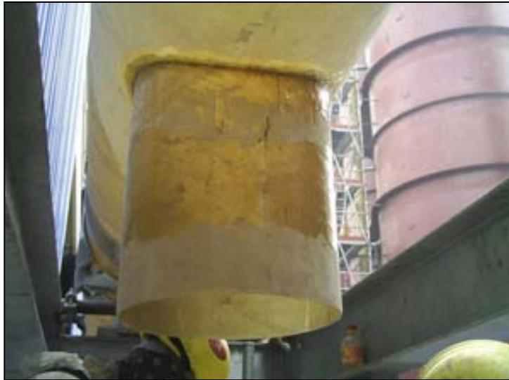
**Figura 5.13** Unión para aplicar capas estructurales (Fotos tomadas por la autora)
