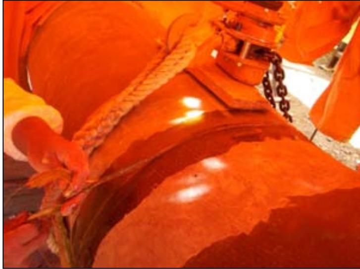
**Figura 5.10** Colocación del roving (Fotos tomadas por la autora)
