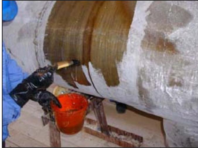
**Figura 4.35** Aplicación de resina (Kvaerner, 2005)
