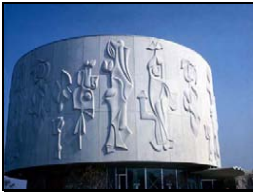
Imagen 2-2.- Vista Panel Arquitectónico reforzado con Fibra de Vidrio.
