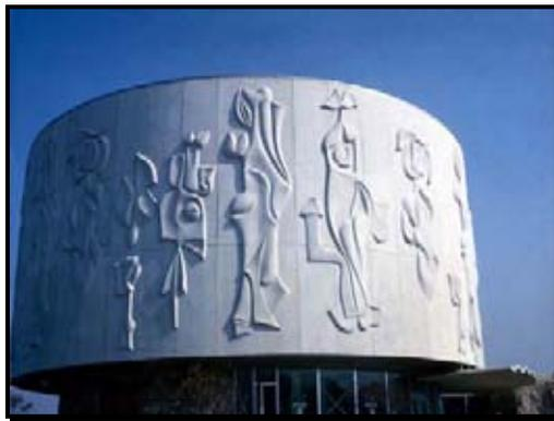
**Imagen 2-2.- Vista Panel Arquitectónico reforzado con Fibra de Vidrio.**
