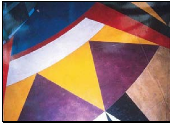
Imagen 2-4.- Azulejos enlazados con cemento blanco
