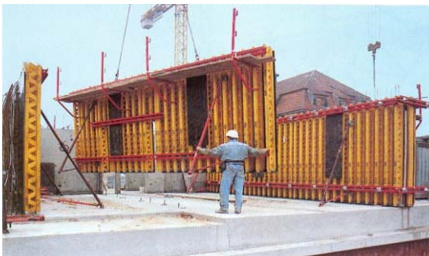
FIGURA 7: Moldajes monolíticos de muros. Cortesía Empresa PERI.
