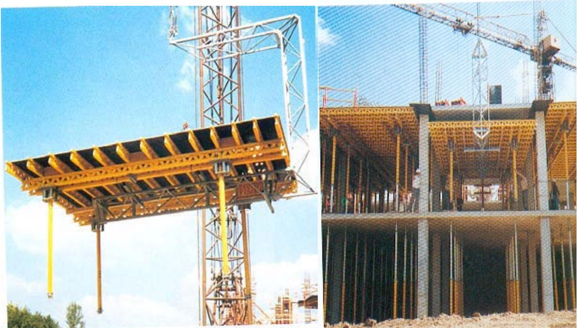
FIGURA 2: Moldaje con placa de madera, vigas secundarias, vigas principales y puntales: mesas voladoras. Marca Peri
