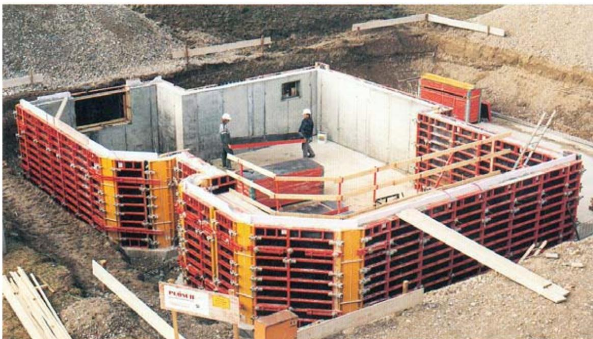
FIGURA 5: Moldajes conformados por pequeñas piezas desmontables. Cortesía Empresa PERI.
