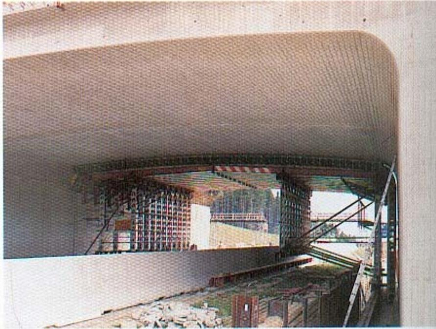
FIGURA 8: Moldajes de una sola fase (túneles). Hormigón visto con acabado de tabla machihembrada . Asesoramiento del proyecto: PERI Alemania
