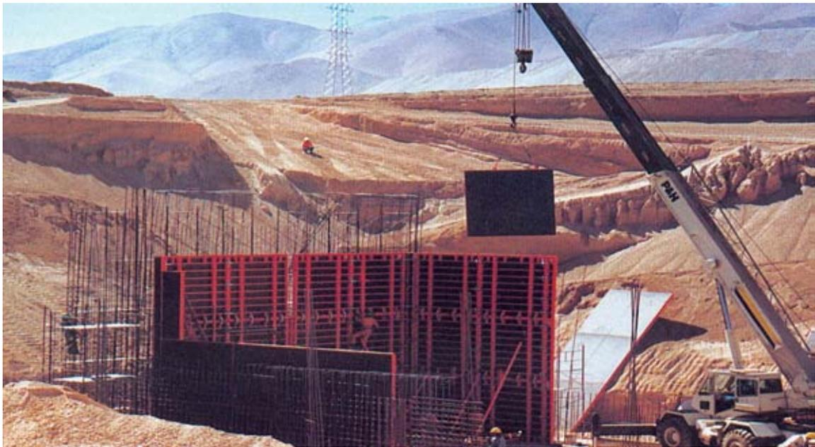
FIGURA 6: Moldajes conformados por piezas modulares.
