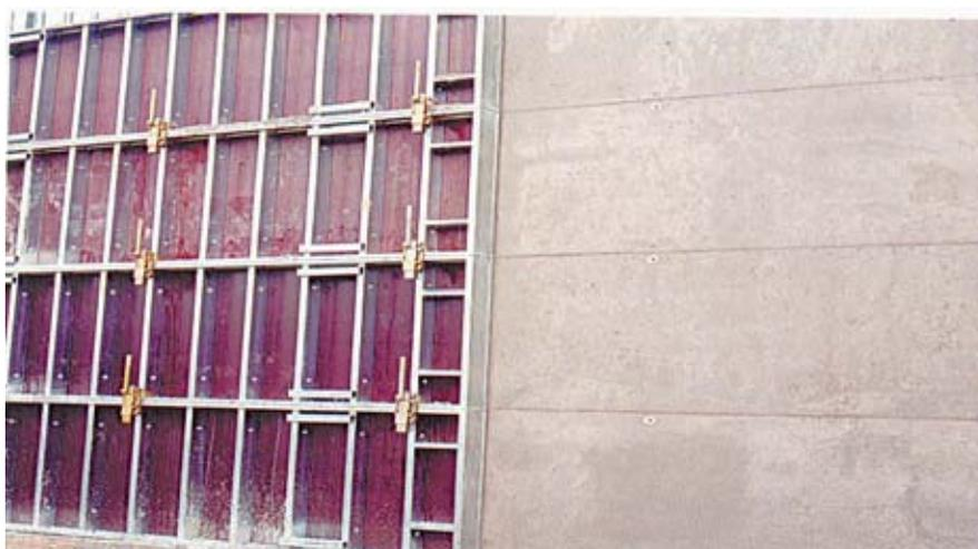
FIGURA 1: Moldaje liviano estructurado en acero con placa de madera recubierta en resina fenólica con terminación lisa, marca Alsina.
