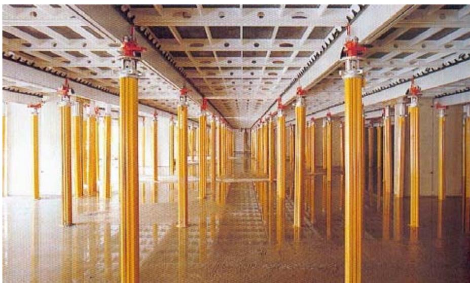
FIGURA 4: Elementos de aluminio en losa. Gentileza PERI.
