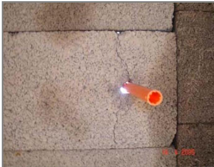
**Fotografía N° 18 Perforación incorrecta en bovedilla para pasada de tubo eléctrico (Conduit).**
