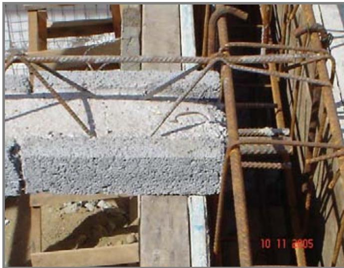
**Fotografía N° 11 Apoyo vigueta en moldaje de Cadena.**
