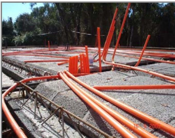
**Fotografía N° 14 Canalización Eléctrica sobre bovedillas.**
