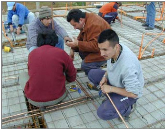
*Fotografía N° 19 Canalización agua potable.*
