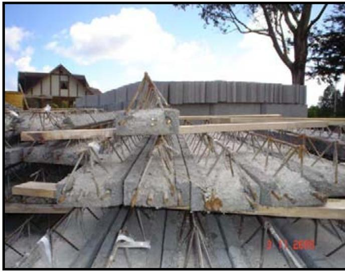
**Fotografía Nº 2 Vigueta compuesta de Terliz y placa base de hormigón.**
