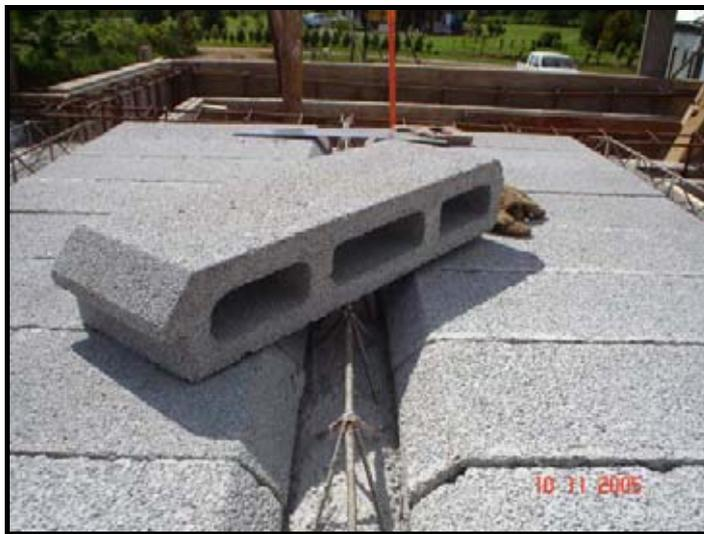
***Fotografía N° 4 Bovedilla de hormigón.***
