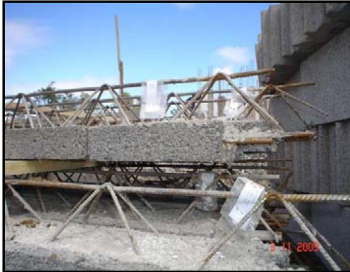
**Fotografía N° 3 Vista lateral vigueta tralizada.**
