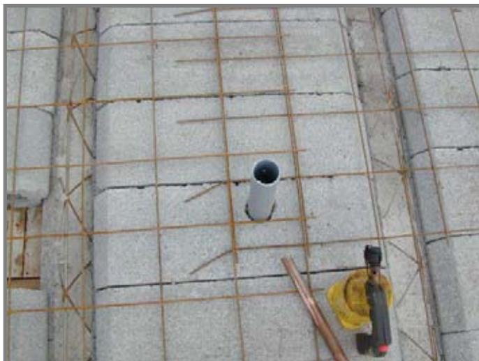
**Fotografía N° 21 Perforación sanitaria correcta en bovedilla.**
