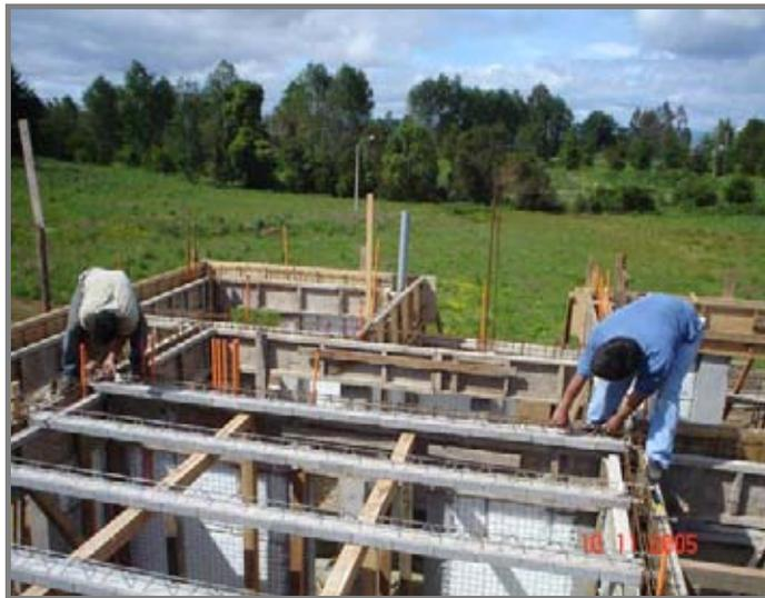
**Fotografía N° 9 Colocación de Viguetas.**
