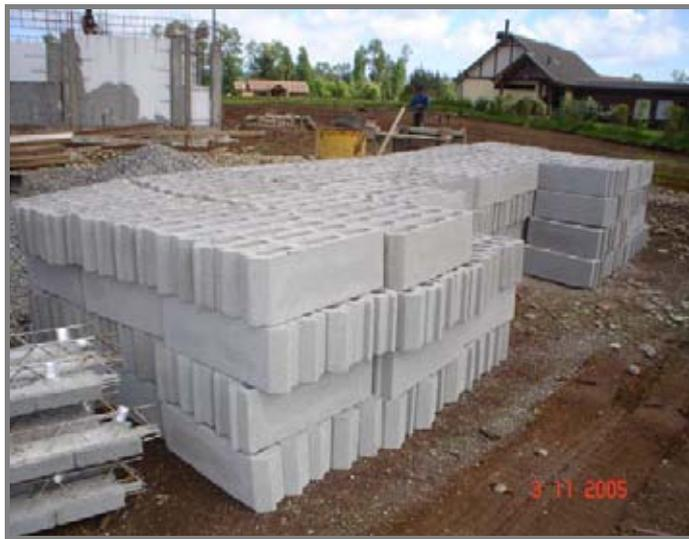
**Fotografía N° 6 Apilado Bovedillas.**
