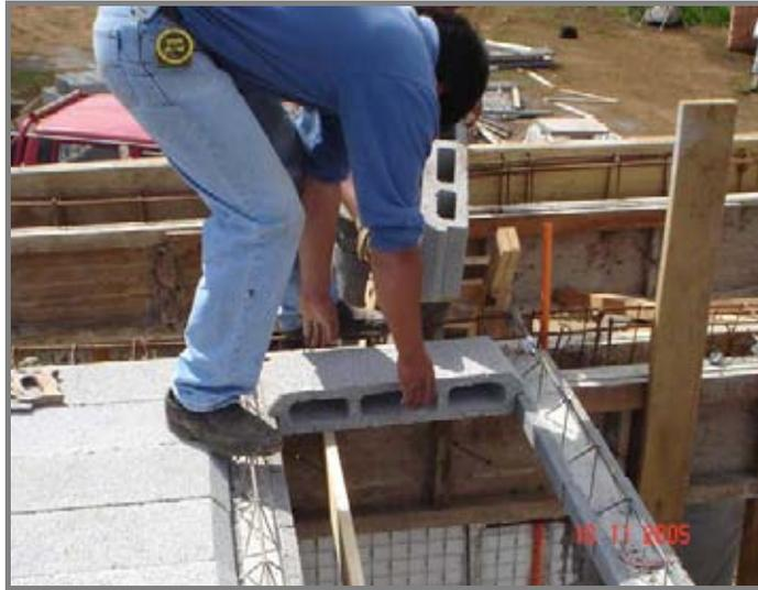
**Fotografía N° 12 Instalación Bovedillas.**
