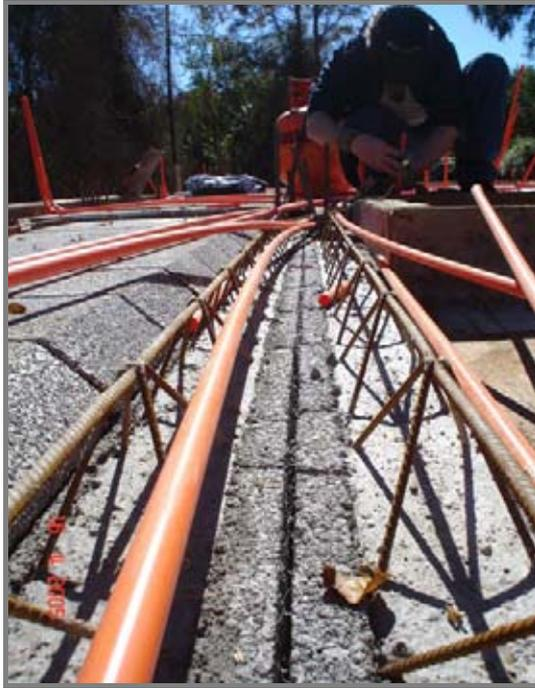
**Fotografía N° 15 Canalización Eléctrica en dirección a las vigueta.**
