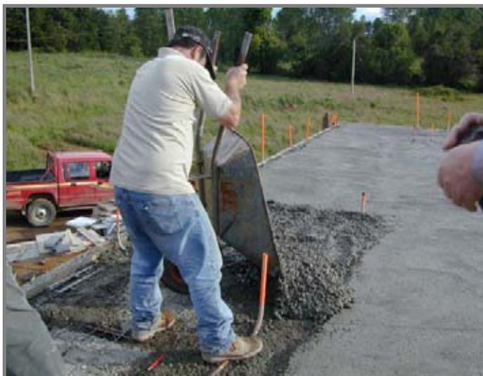
**Fotografía Nº 27 Vaciado de hormigón sobre losa.**
