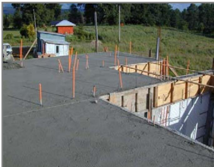
**Fotografía Nº 30 Losa concretada en bruto.**
