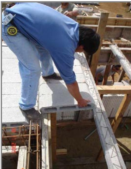
**Fotografía N° 13 Instalación Bovedillas.**
