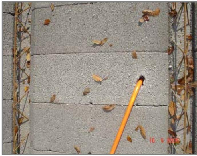
**Fotografía N° 17 Perforación correcta en bovedilla para pasada de tubo eléctrico (Conduit).**
