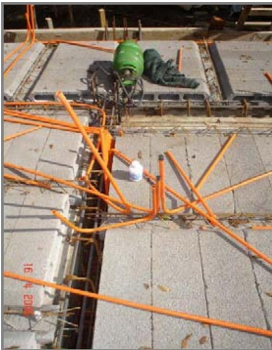
**Fotografía N° 16 Canalización Eléctrica.**
