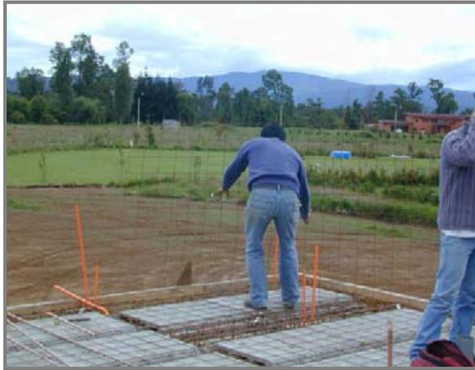
***Fotografía N° 22 Instalación malla ACMA de sobrelosa.***
