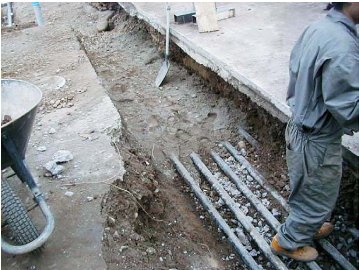
En la fotografía se aprecian 4 líneas de Impulsión, sobre ellas una cama de arena.
