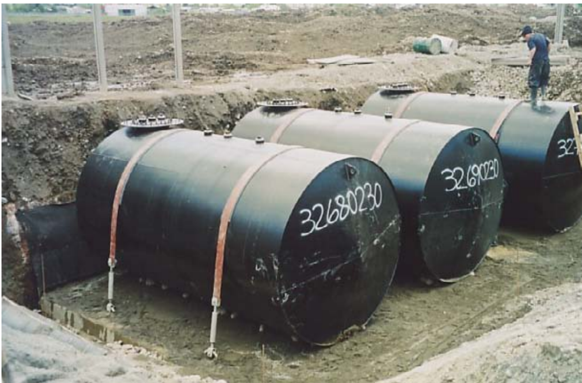
En la fotografía se aprecian tres estanques instalados y amarrados a la losa de anclaje.
