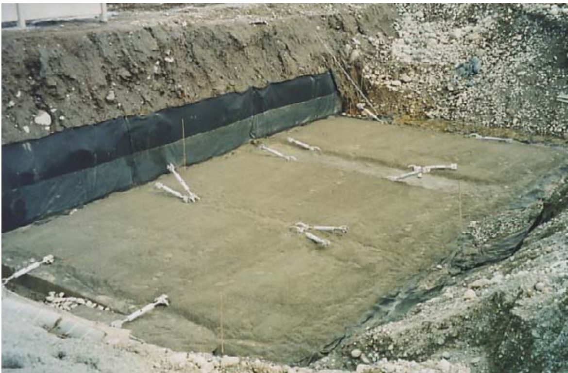
En la fotografía se aprecia la cama de arena sobre la losa, y los tensores colocados sobre los ganchos omega.
