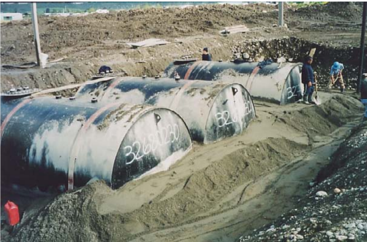
En la fotografía se aprecia el relleno con arena de 3 estanques.
