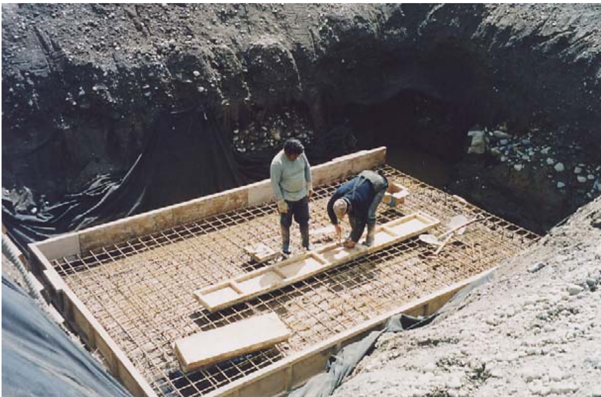
En la fotografía se aprecia la construcción de una pequeña losa que sostendrá un estanque de 20 m 3 .
