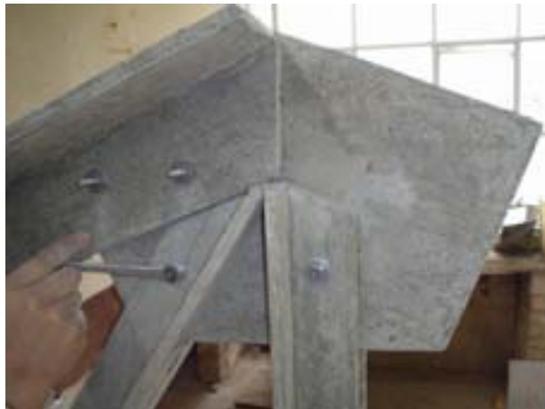
fig. No 43 Instalación de diagonales.
