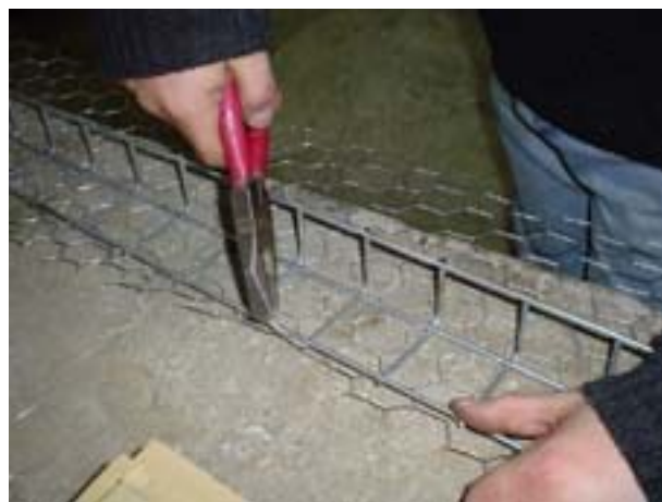
fig. No 28 Colocación de la malla hexagonal.
