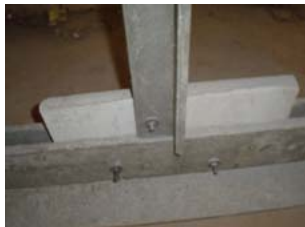
fig. No 38 Montante unido a cordón inferior (tirante).
