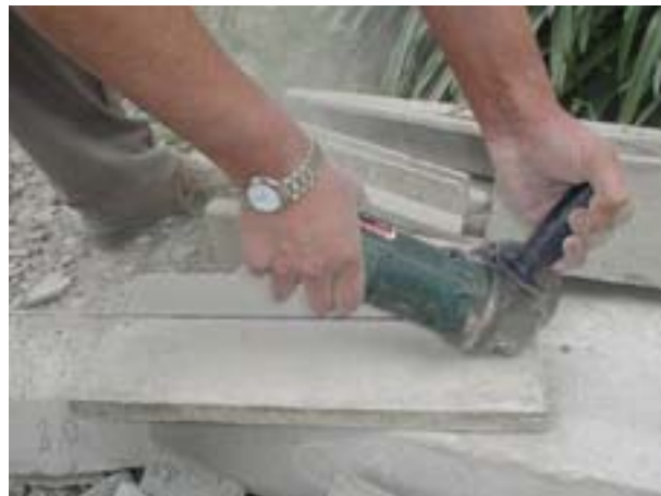
fig. No 35 Corte de placas de ferrocemento para las uniones.
