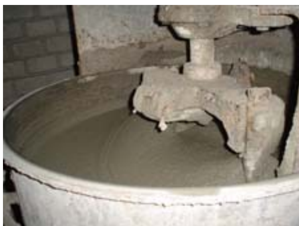
fig. No 30 Mezclado del mortero.
