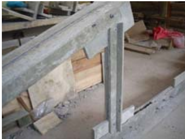
fig. No 40 Parte del cordón superior instalado.
