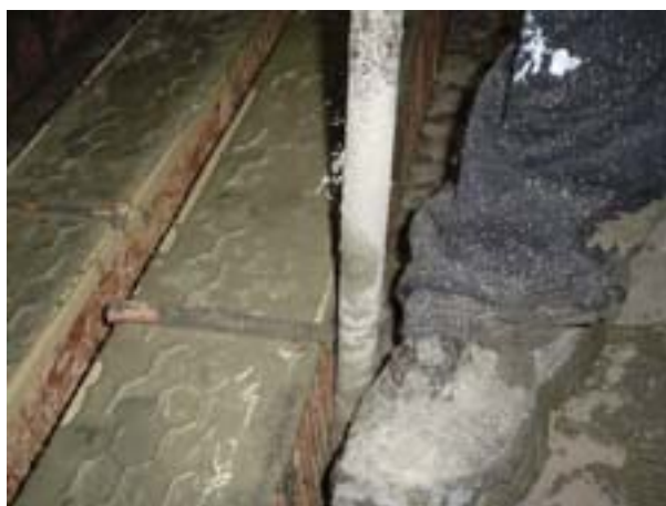
fig. No 32 Proceso de vibrado.
