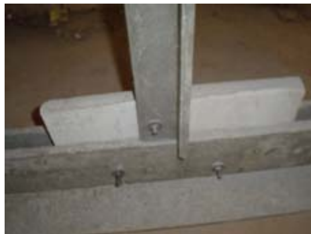
fig. No 38 Montante unido a cordón inferior (tirante).
