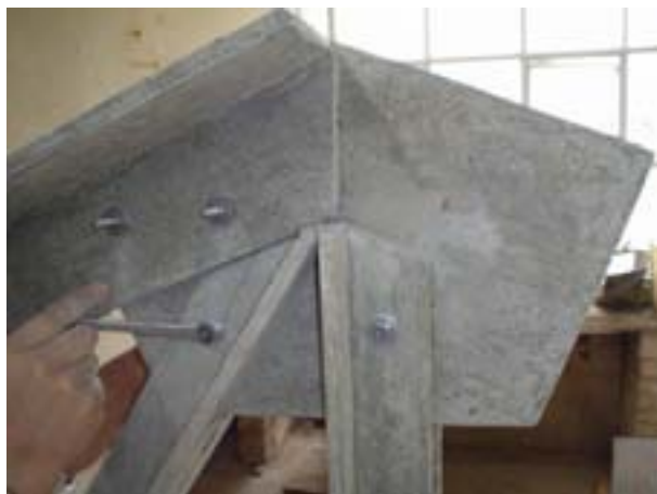
fig. No 43 Instalación de diagonales.
