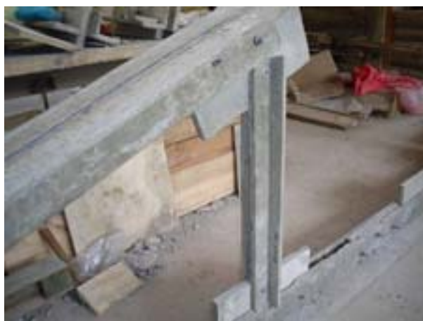
fig. No 40 Parte del cordón superior instalado.
