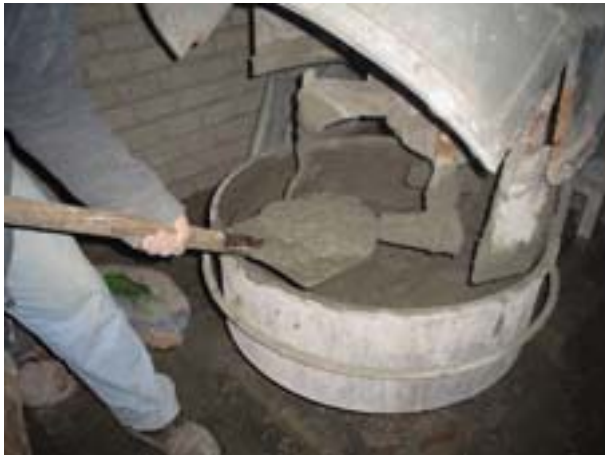
fig. No 31 Vaciado de la mezcla.
