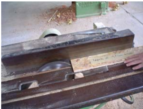
fig. No 24 Construcción de moldajes de OSB 9,5 mm.
