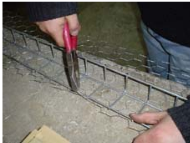
fig. No 28 Colocación de la malla hexagonal.
