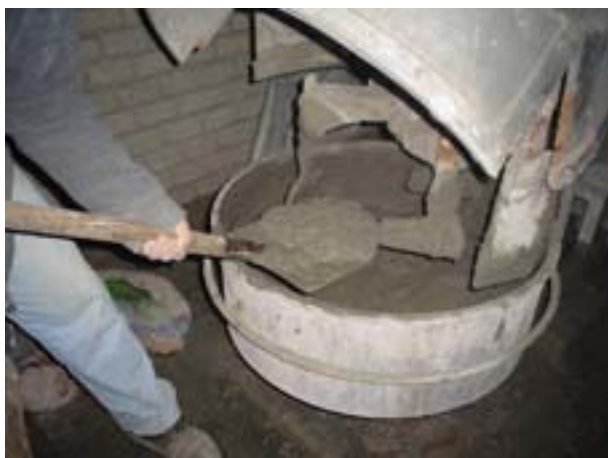
fig. No 31 Vaciado de la mezcla.
