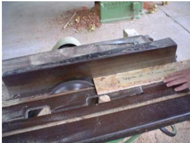
fig. No 24 Construcción de moldajes de OSB 9,5 mm.
