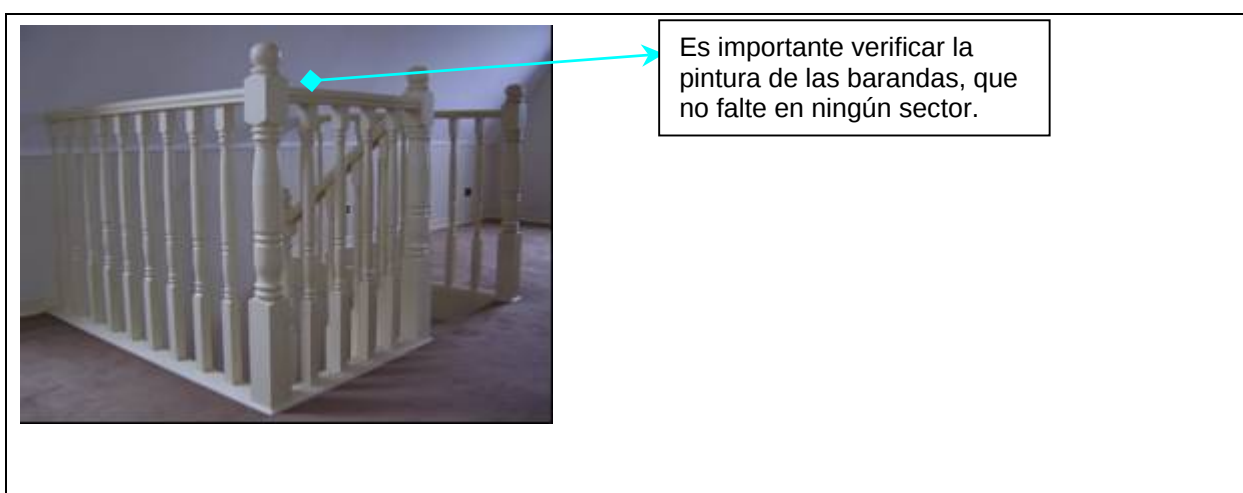
Figura N° 8: Inspección de escalera.
