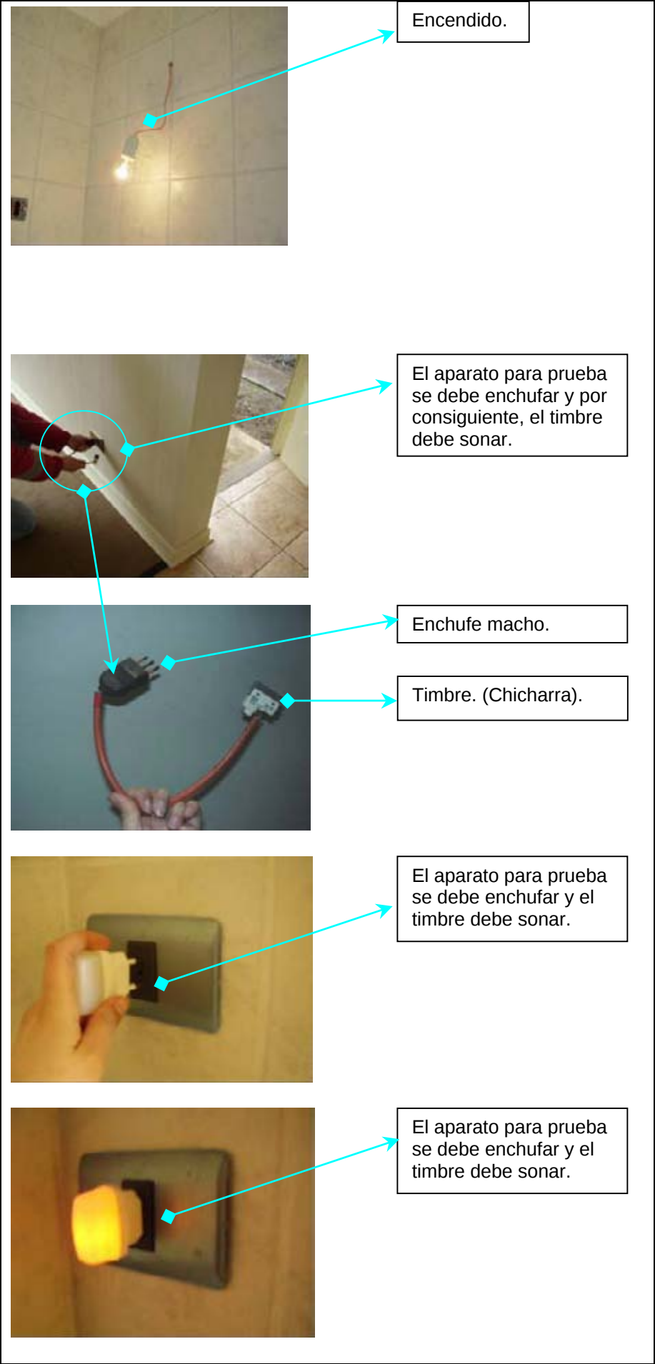
Figura N° 7: Prueba de funcionalidad eléctrica.
