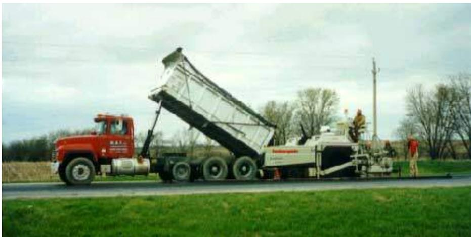
Una vez confeccionadas las mezclas en la planta estas deberán transportarse a los lugares de colocación en camiones tolva convenientemente preparados para ese objeto. Las condiciones de la mezcla a la salida del mezclador y a la llegada a su punto de empleo deben ser iguales.
