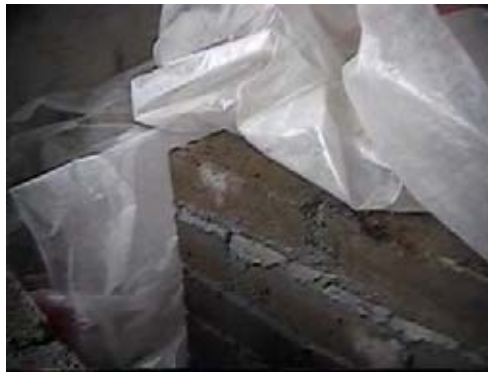
Foto nº 15. Murete cubierto por polietileno.
