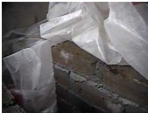
Foto nº 15. Murete cubierto por polietileno.
