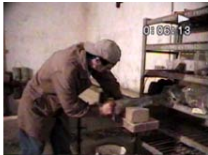
Foto nº 37. Corte de bloque con serrucho.
