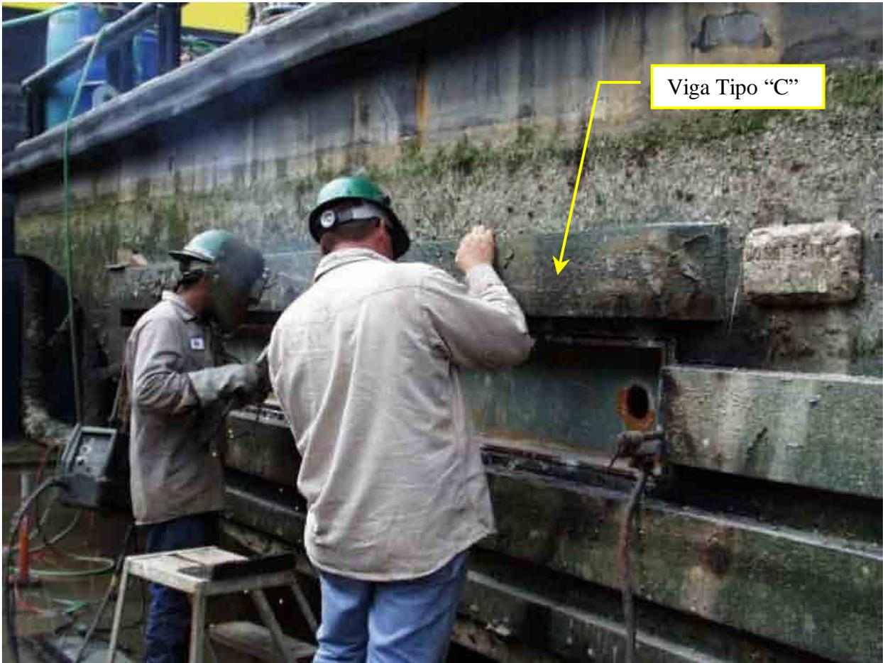
fig 1.2.13. Enfriadores de quilla tipo estructurales (Vigas tipo C)
