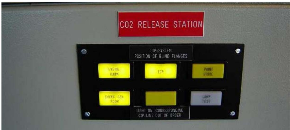
Fig 3.1.7 -3) Panel de alarmas ópticas del sistema de CO<sub>2</sub>.
