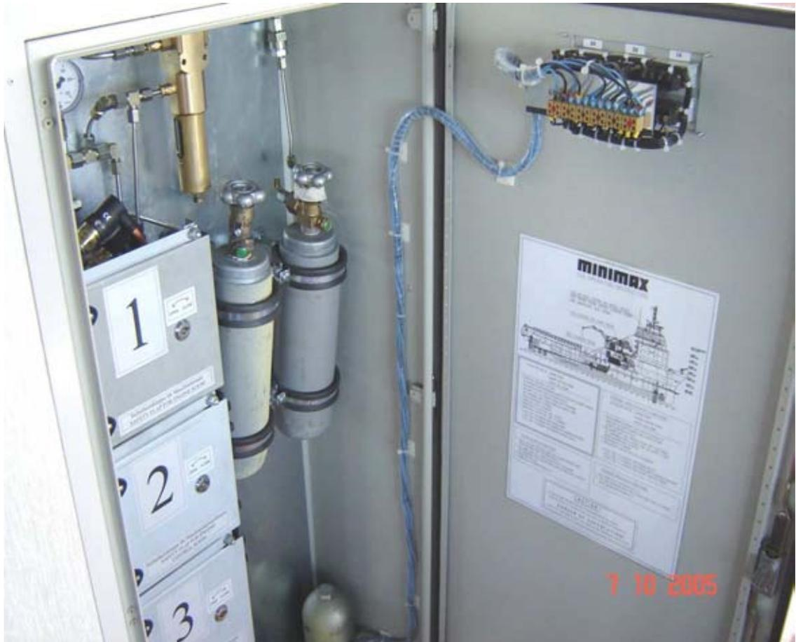
Fig. 3.1.9 -4) Cuadro indicativo de operación ubicado detrás de la tapa de la release station, en puente de gobierno.
