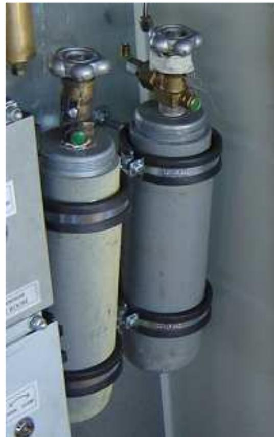
Fig. 3.1.3 botellas pilotaje de CO<sub>2</sub> ubicada en wheelhouse.
