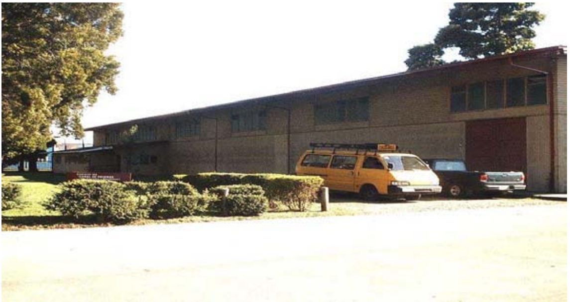
Figura N°4. Edificio 100, Canal de Pruebas, Campus Miraflores.
