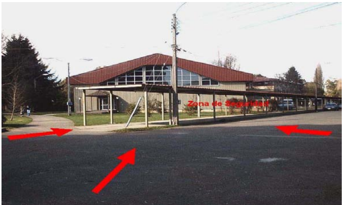
Figura N° 9. Zona de seguridad vista desde edificio Ciencias Navales.
