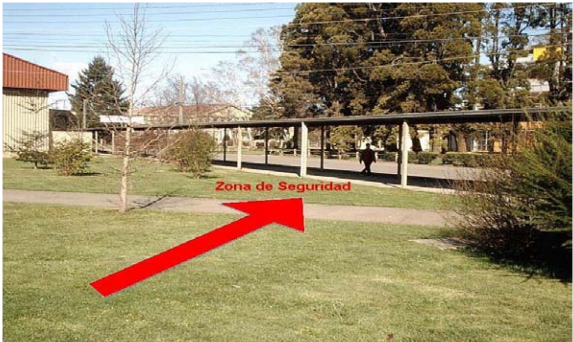
Figura N°8. Zona de Seguridad, Pasillo Techado, Vista desde casino, Campus Miraflores.
